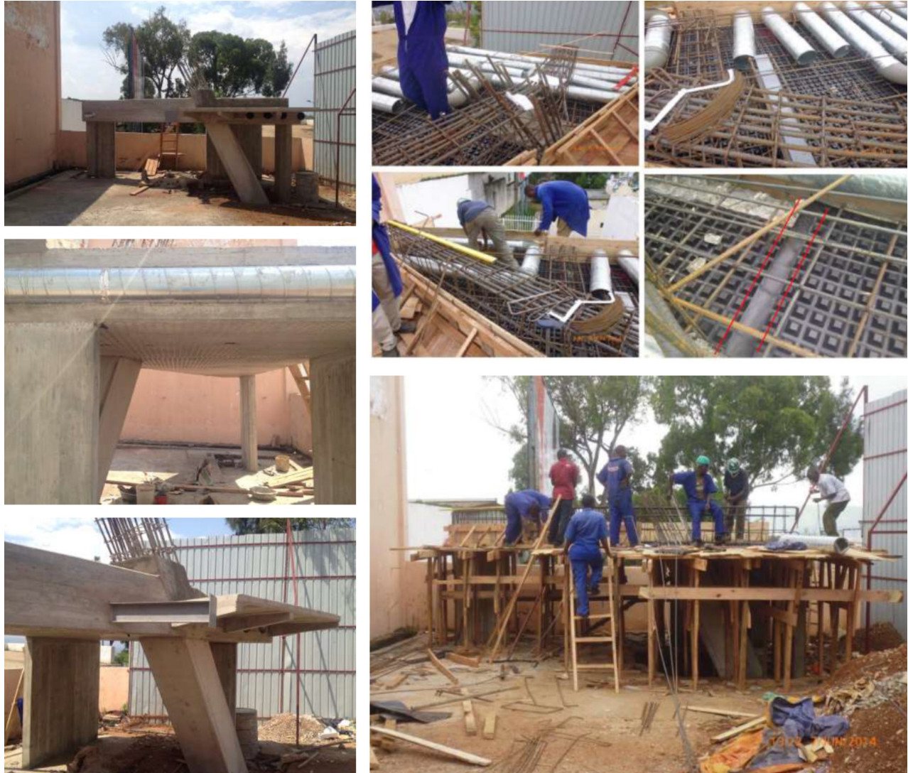
Figura 9. Construcción en obra un mock-up de la estructura con conductos para probar el sistema.
