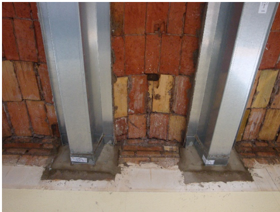
Figura 5. Forjados con viguetas de hormigón reforzados y bovedillas de cerámica.
