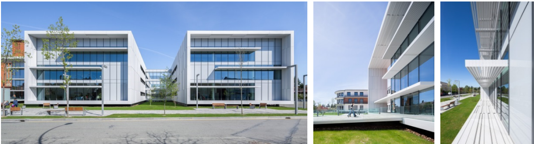
Figura 7. Voladizos fachada ampliación del Hospital San Juan de Dios, Pamplona.
