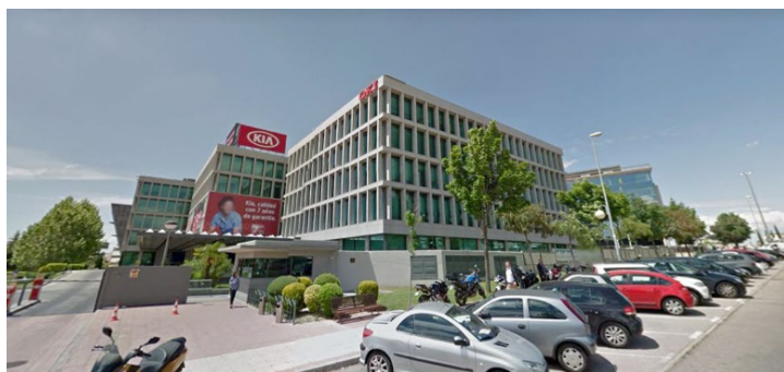
Figura 4. Fachada Sureste. OVC.
