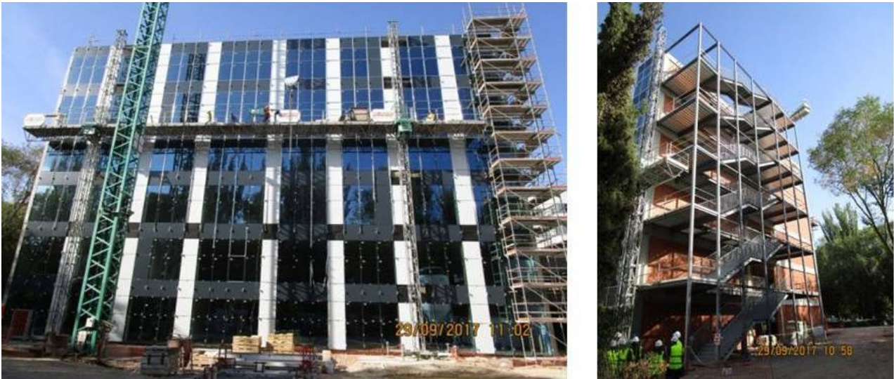
Figura 2. Diseños diferentes para cada fachada: muro cortina y futuro muro fotovoltaico (Sept. 2017).
