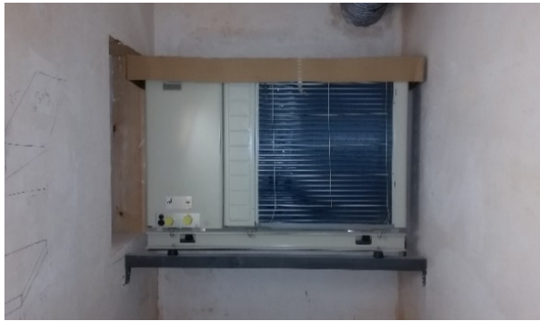
Figura 3. Bomba de calor aire-agua monobloc.
