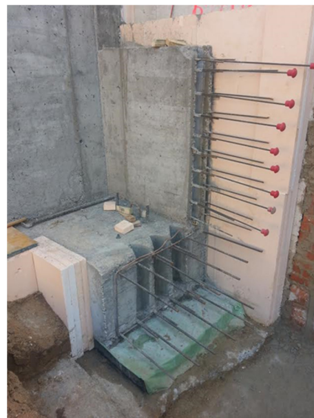
Figura 4. Aislamiento de Cimentación.
