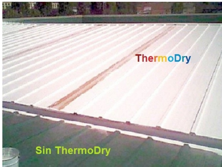
Figura 1. Cubierta metálica tratada con pintura termo-reflectante ThermoDry.
