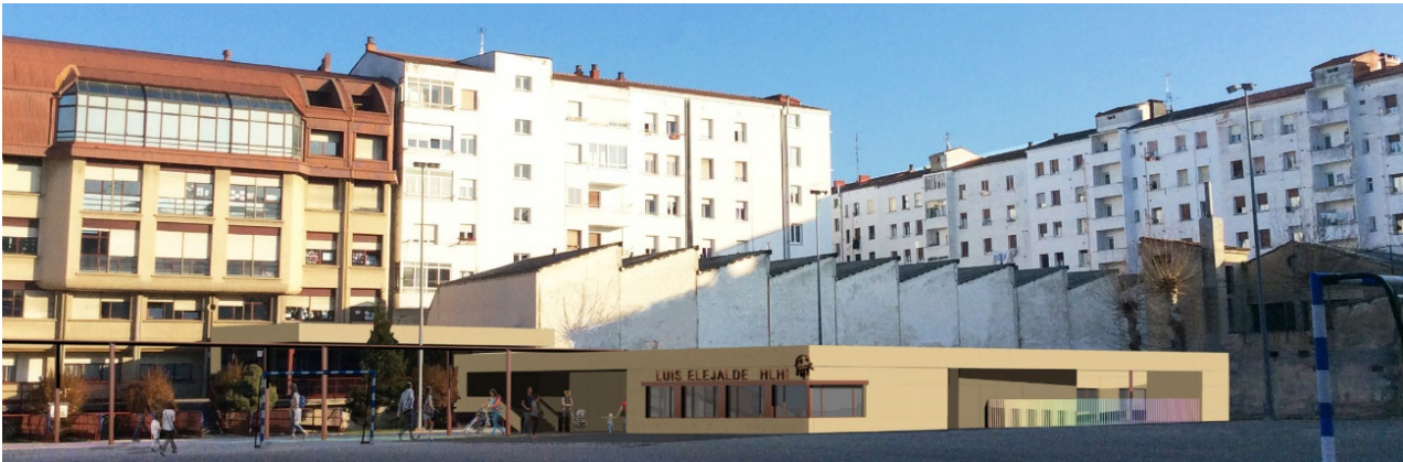
Figura 1. Vista de las Fachadas Captadoras SE y SO.
