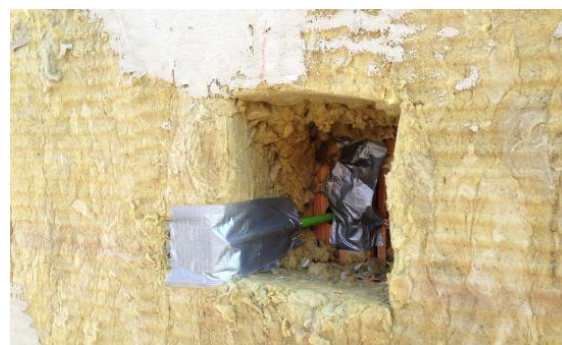
Figura 5. Colocación de sensores (termopares) en fachada.
