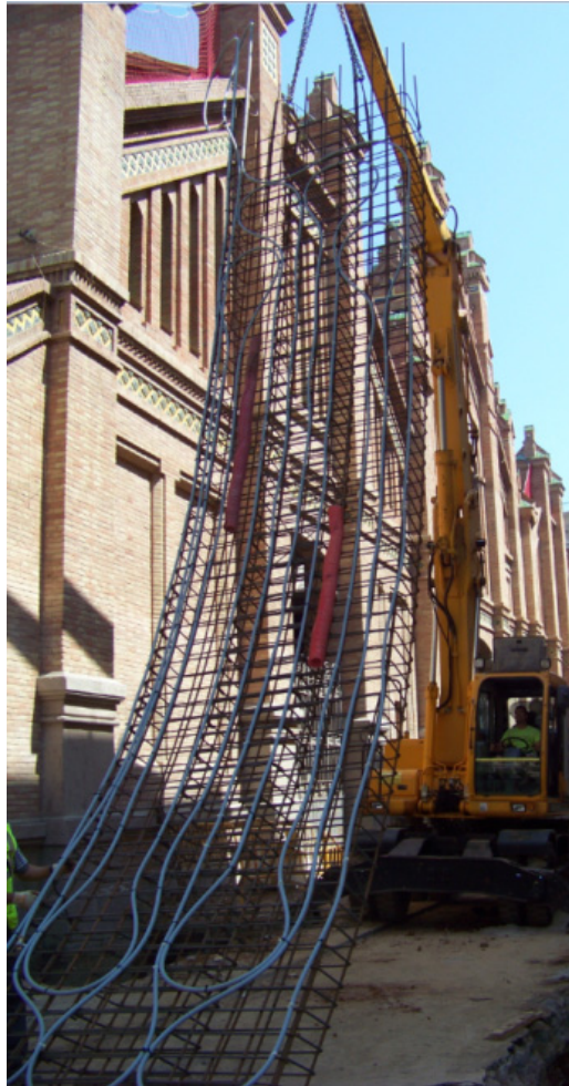
Figura 2. Instalación del muro pantalla termoactivado.
