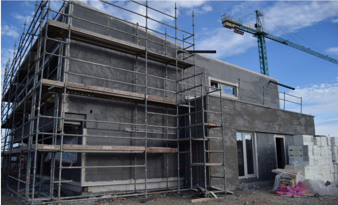
Imagen 7. Vista general de vivienda previo a acabados exteriores.
