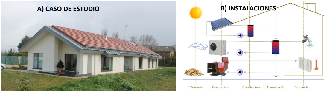
Figura 1. Vivienda unifamiliar monitorizada en Álava (a) y sus instalaciones de calefacción y ACS (b).
