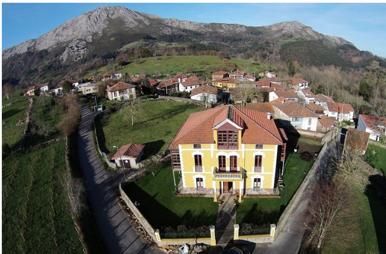
Figura 1. Casona de Indianos_Estado Previo a Rehabilitación Enerphit.
