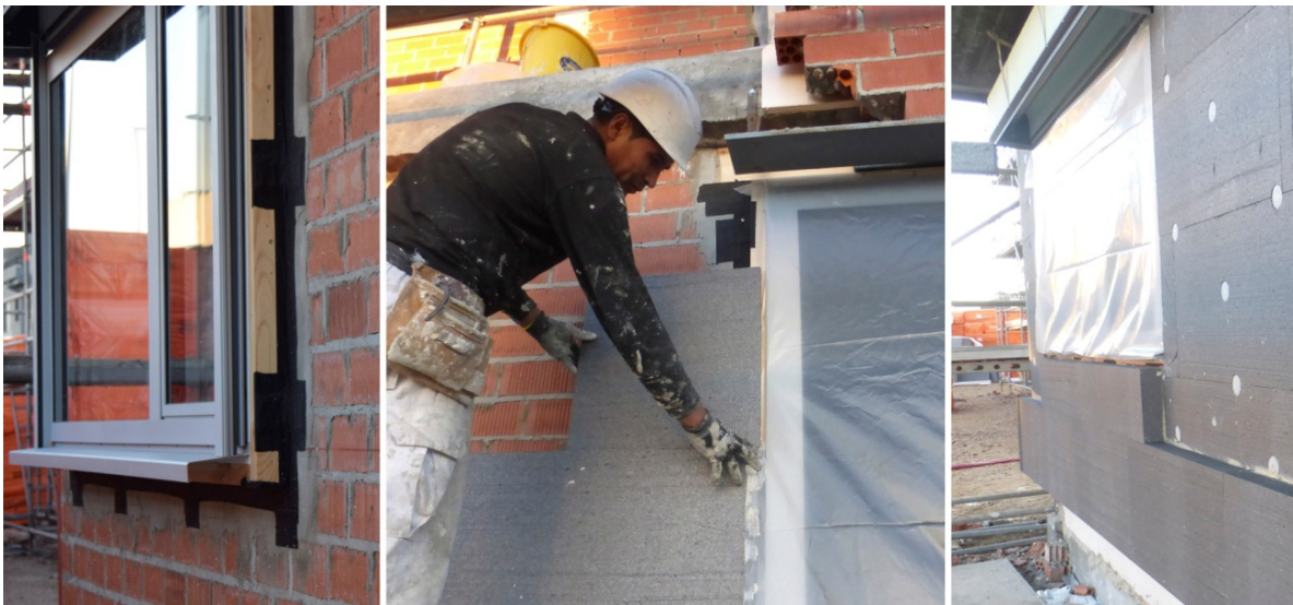
Imagen 6. Detalle de instalación de carpinterías y SATE.
