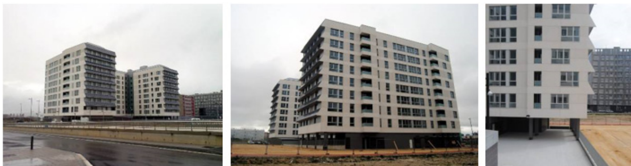
Figura 1. Diferentes vistas del edificio de 171 viviendas sociales terminado.
