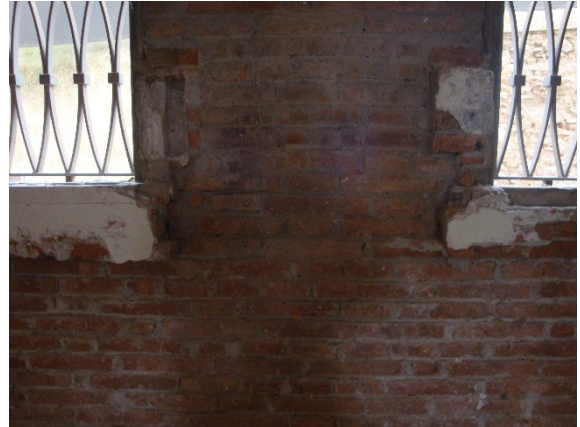
Figura 4. Vista de la cara interior de los muros de fachada.
