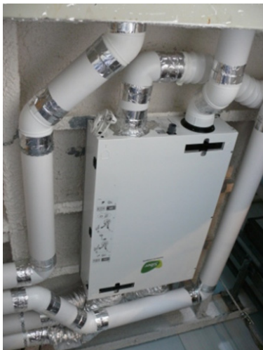
Figura 2. Foto del equipo de ventilación instalado en la vivienda (Izq.), y esquema del sistema de ventilación (Dcha.).
