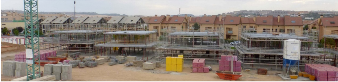
Imagen 4. Ejecución de estructura.
