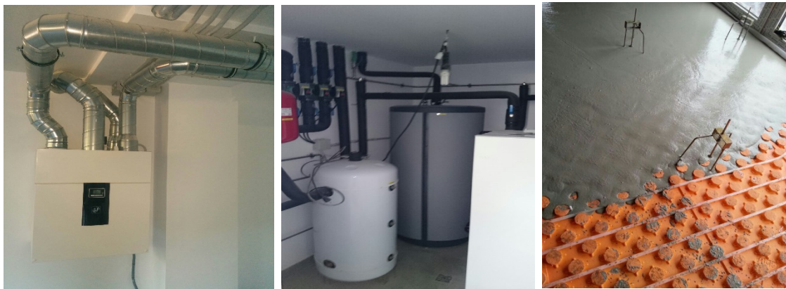
Figura 4. a) Recuperador de calor b) Instalaciones térmicas c) Suelo radiante.
