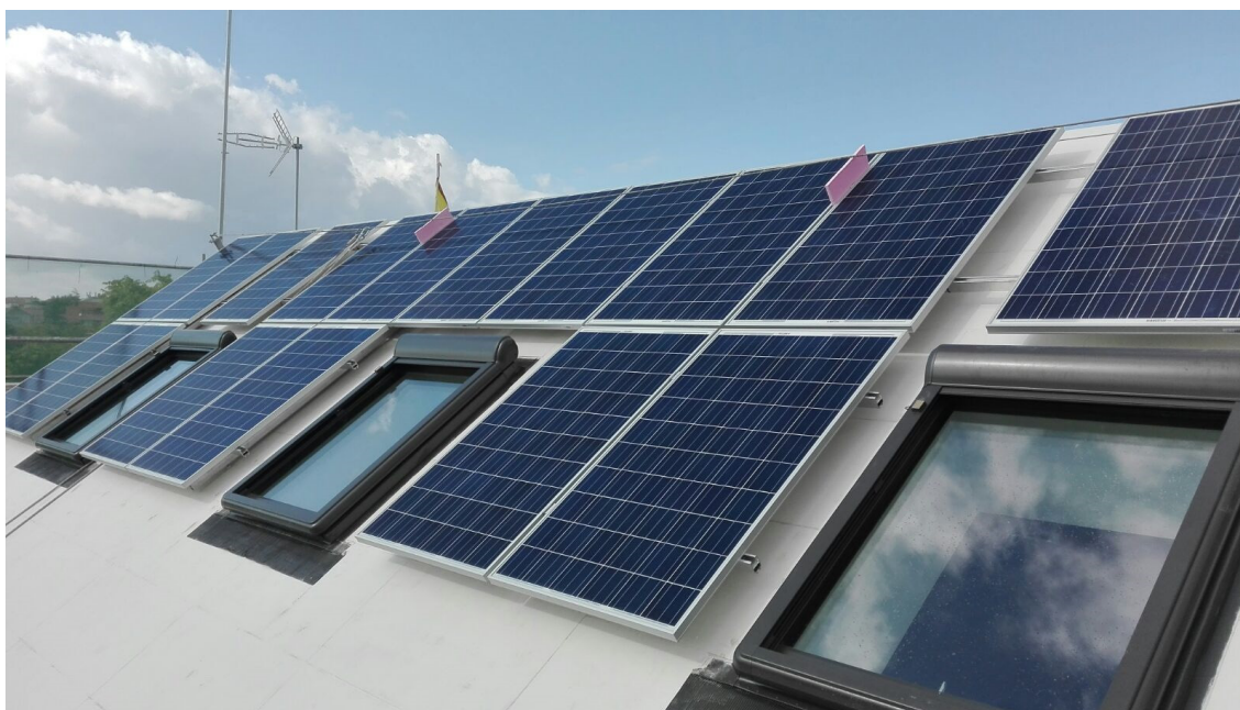
Figura 7. Instalación fotovoltaica en cubierta Sur.
