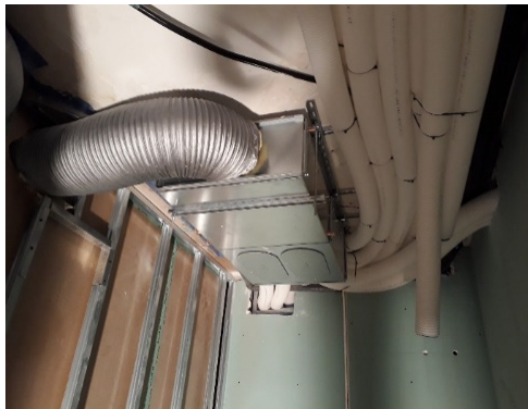
Figura 5. Batería de agua & silenciador.
