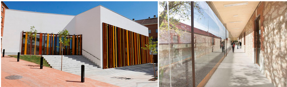
Figura 3. Obra nueva biblioteca en Villamediana (La Rioja) y Rehabilitación Universidad de Burgos.
