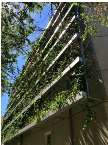
Figura 5. Fachada vegetal Edificio Pez Austral.
