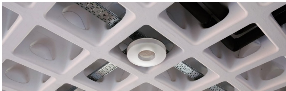
Figura 2. Estructura tipo Holedeck H45 sobre la que se apoyan directamente las instalaciones sin necesidad de falso techo.
