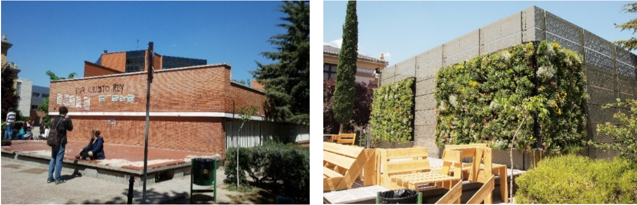
Figura 1. Infraestructura antes y después de ser rehabilitada. Fuente propia.
