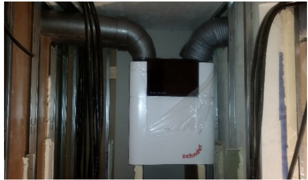
Figura 4. Recuperador de calor entálpico.
