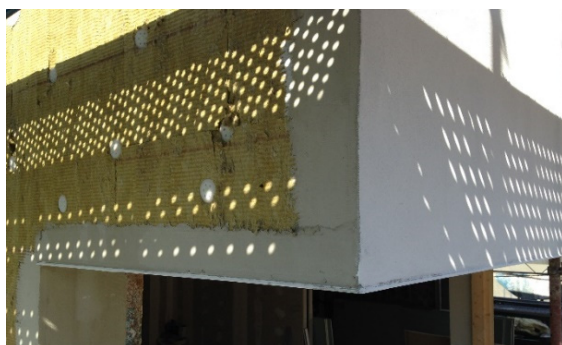
Figura 4. Detalle de instalación de REDArt.
