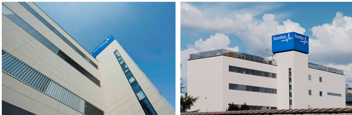
Figura 1. Fachada del edificio. & Figura 2. Perspectiva de toda la fachada del edificio de la parte frontal.
