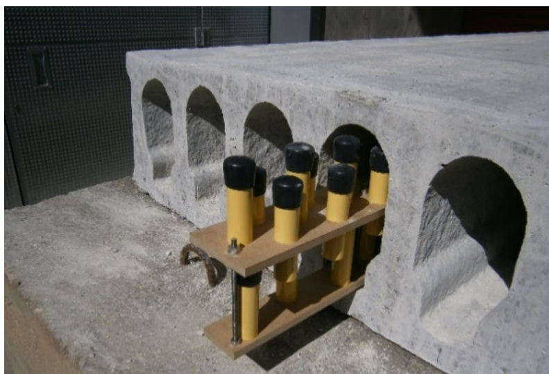
Figura 3. Colocación de encapsulado con PCMs dentro de los huecos de una placa alveolar prefabricada.
