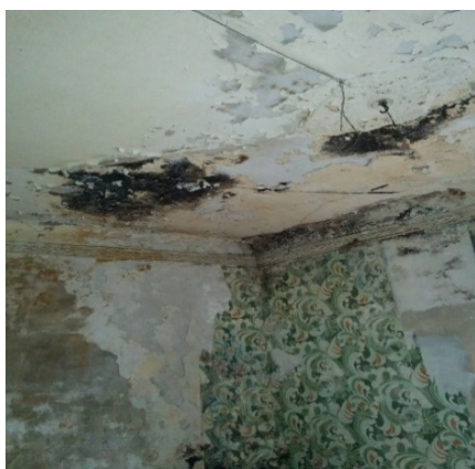
Figura 3. Estado inicial de forjados.
