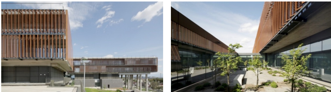
Figura 4. Sistema de Brise soleil en fachadas del Military Medical Center (SAMMC) Houston.
