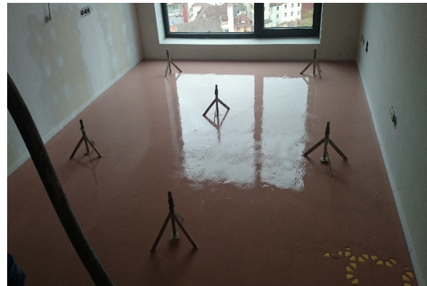
Figura 7. Solera sobre suelo radiante.
