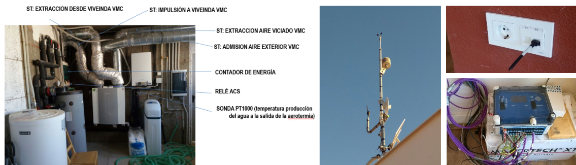
Figura 2. Sistema de monitorización.
