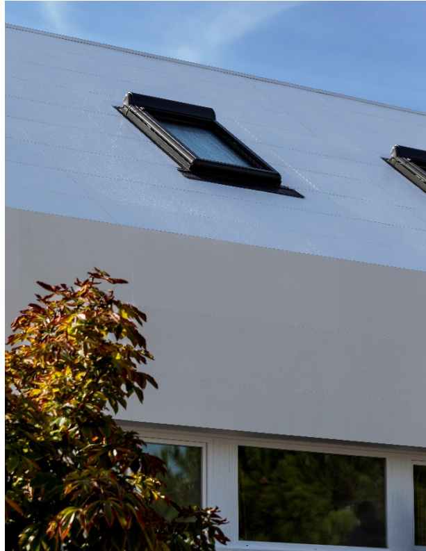
Figura 9. Encuentro fachadas cubiertas en continuidad.
