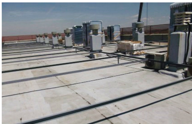
Figura 4. Estructura metálica de soportación.
