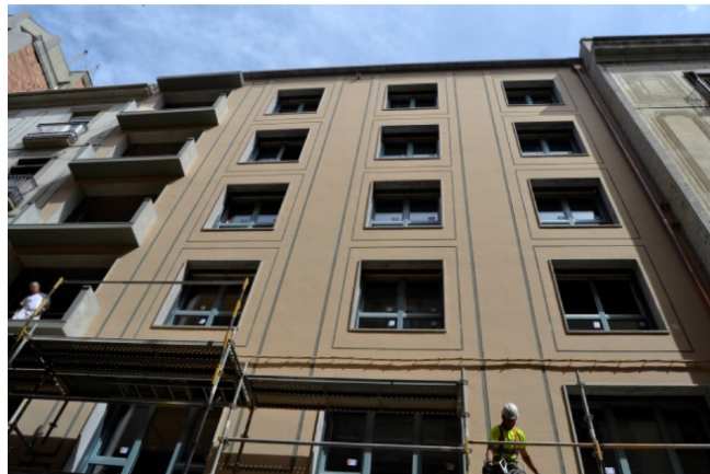
Figura 2. Imagen de la fachada, posterior a la rehabilitación.
