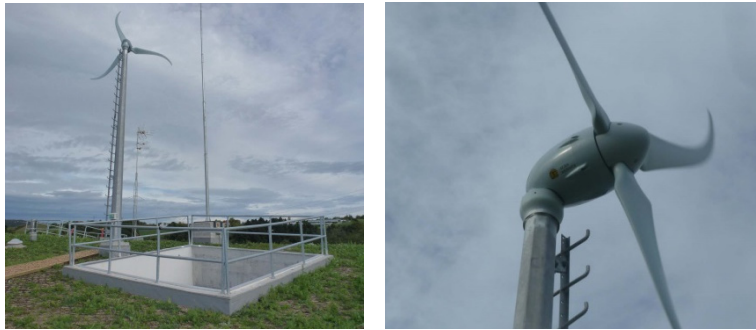
Figura 7. Instalación mini eólica en cubierta.
