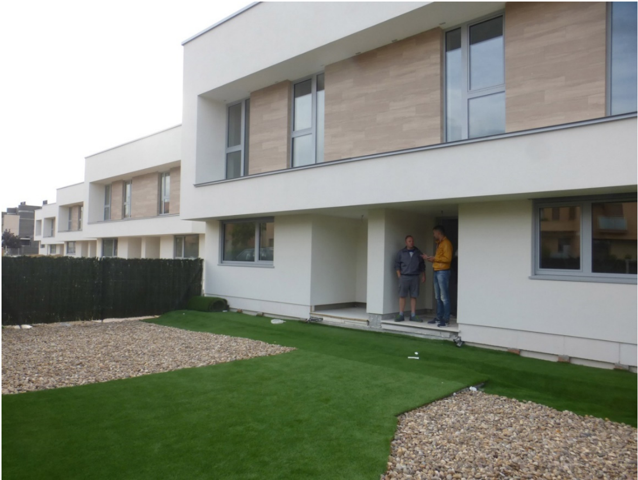
Imagen 9. Vista general de vivienda con acabados II.
