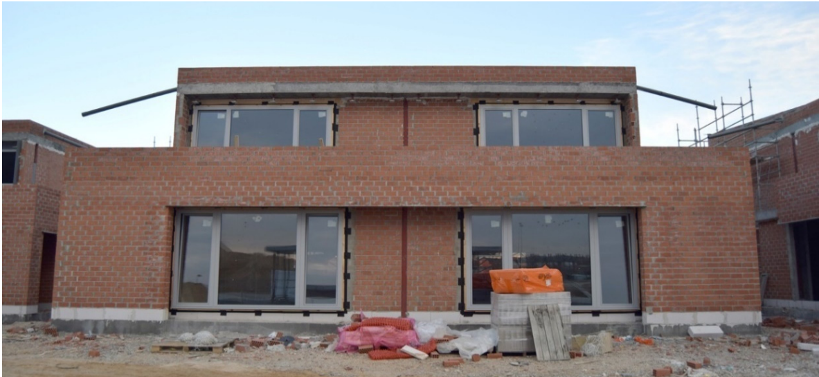
Imagen 5. Ejecución de cerramientos e instalación de carpinterías.
