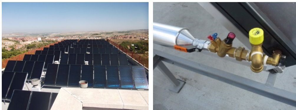
Figura 3. Instalación de los captadores solares en la cubierta.
