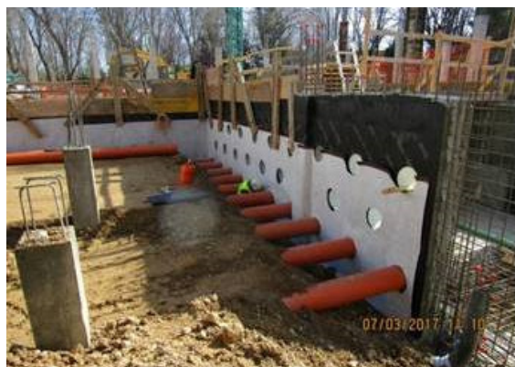
Figura 3. Pozos geotérmicos en construcción y su energía aportada.
