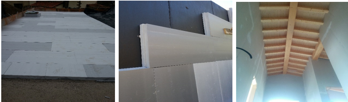
Figura 3. a) Aislamiento bajo losa b) Aislamiento por el exterior muros contención c) Cubierta de madera tradicional.
