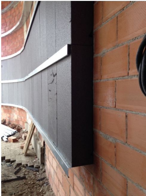
Figura 8. Aislamiento fachada 20 cm.
