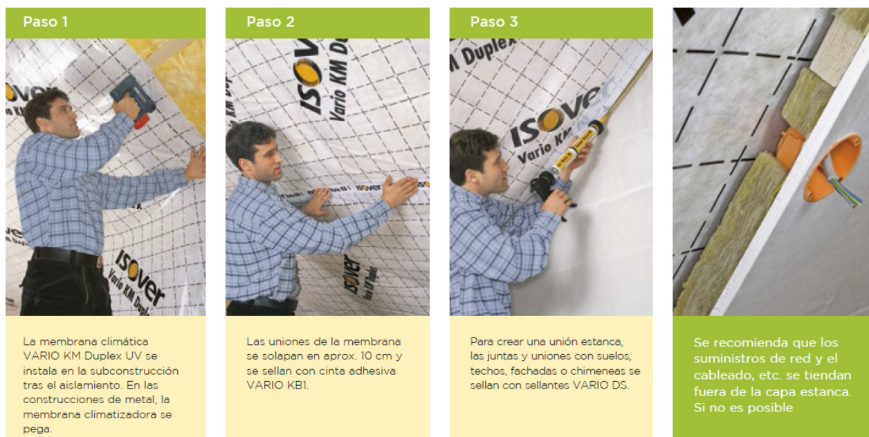
Figura 6. Detalle de instalación membrana de estanqueidad al aire.
