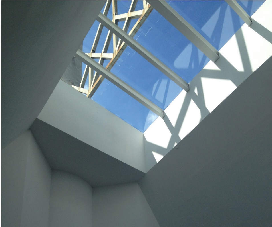
Figura 7. Lucernario hall acceso. Vidrio seguridad cámara argón 12 mm.
