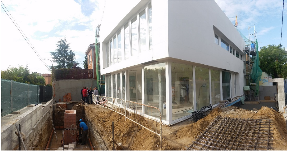
Figura 5. El 80% de la envolvente en planta baja realizado con carpinterías de PVC Kömmerling MD76.
