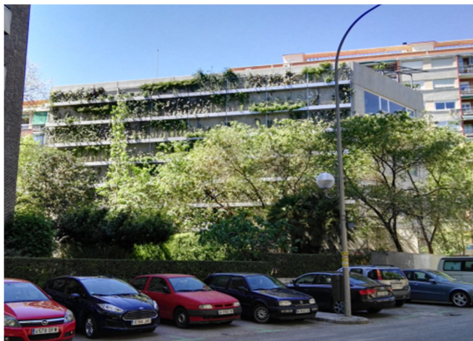
Figura 6. Vista General Edificio Pez Austral.
