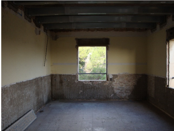
Figura 3. Vista de la cara interior de los muros de fachada.
