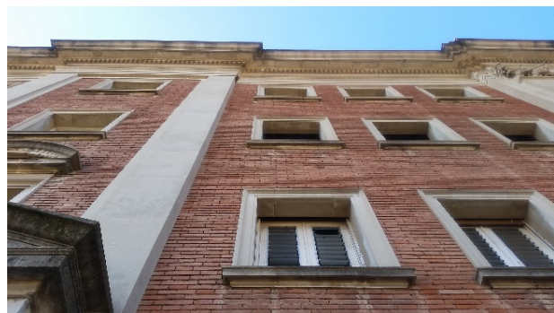
Figura 2. Vista de la fachada de ladrillo cara vista.
