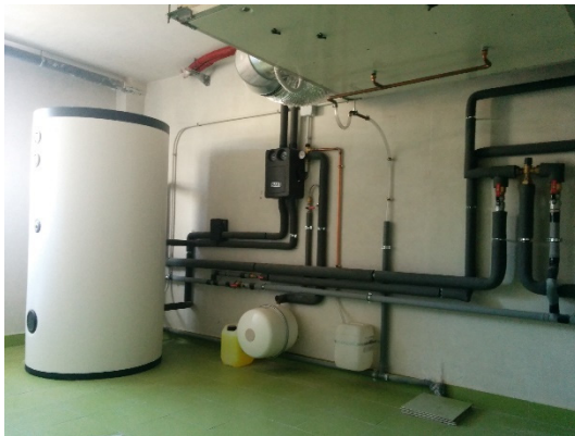
Figura 6. Cuarto instalaciones convencional.
