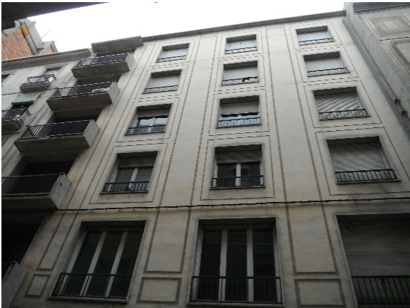
Figura 1. Imagen de la fachada, previa a la rehabilitación.
