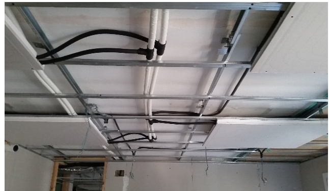
Figura 6. Placas de techo radiante.
