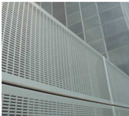
Figura 3. Doble piel vidrio-metal perforado.
