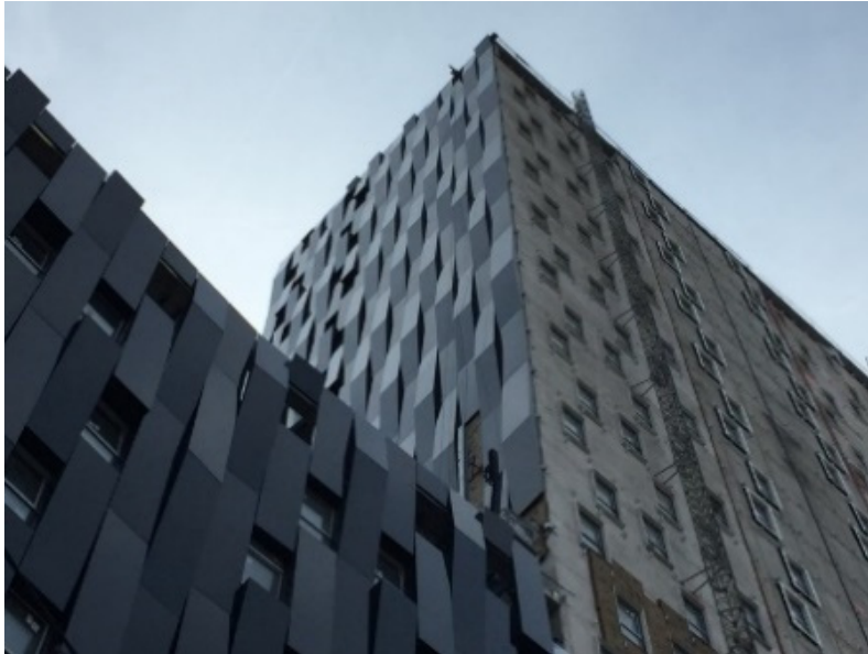
Figura 6. Ejecución de cierre de fachada.
