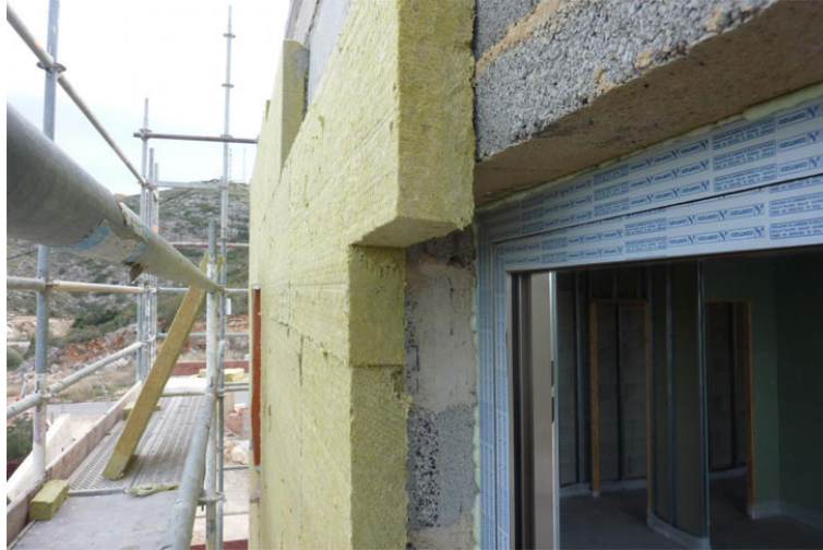
Figura 4. Detalle de SATE en la envolvente.
