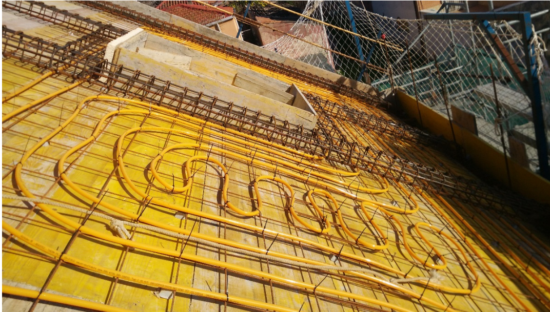
Figura 8. Instalación sistema de refrigeración en losa de cubierta. "Bóveda activa".
