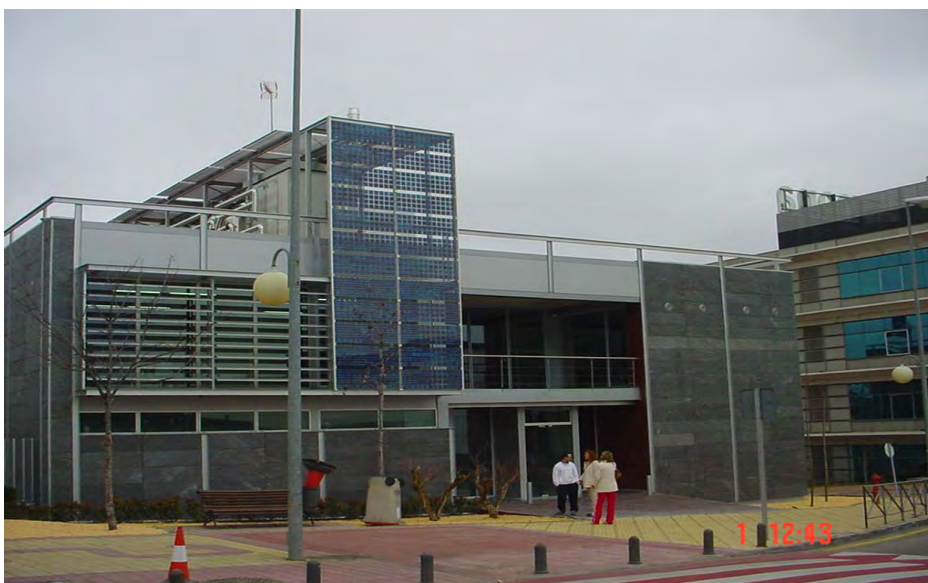
Foto 8. Instalación fotovoltaica integrada en muro cortina.
