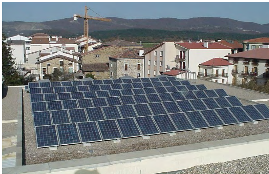
Foto 2. Instalación conectada a red.
