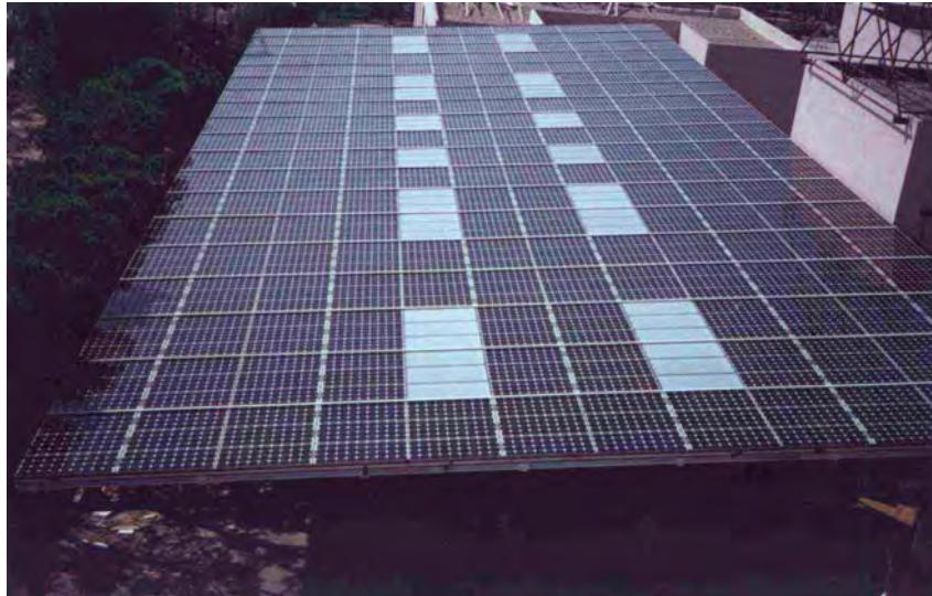
Foto 9. Instalación fotovoltaica integrada en cubierta.
