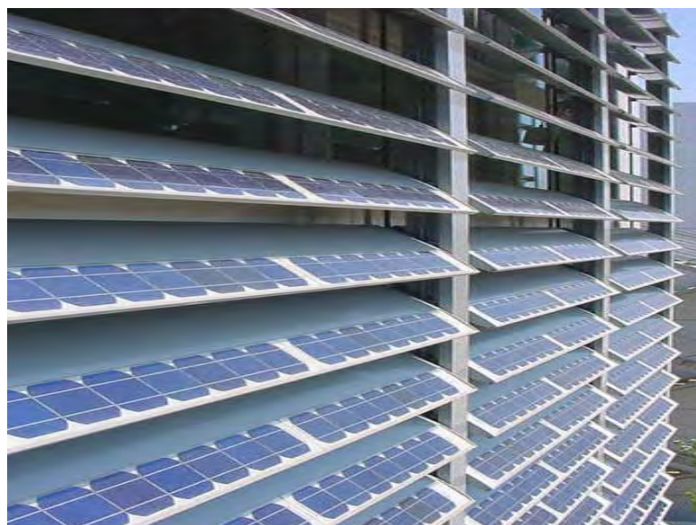
Foto 10. Instalación fotovoltaica integrada en lamas.
