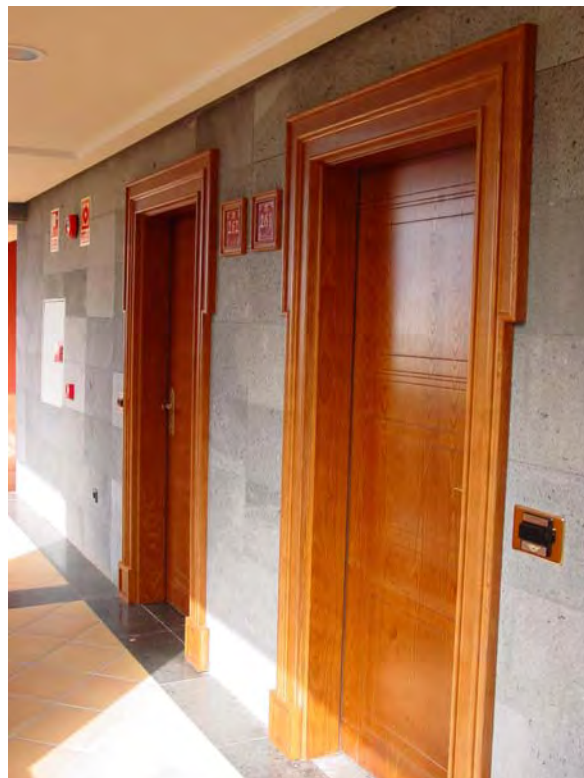
Figura 3. Control de accesos.
