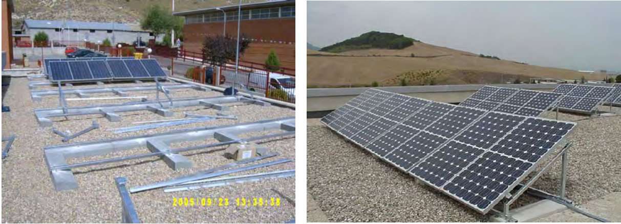
Foto 6. Sistema fotovoltaico sobre tejado plano no perforable.
