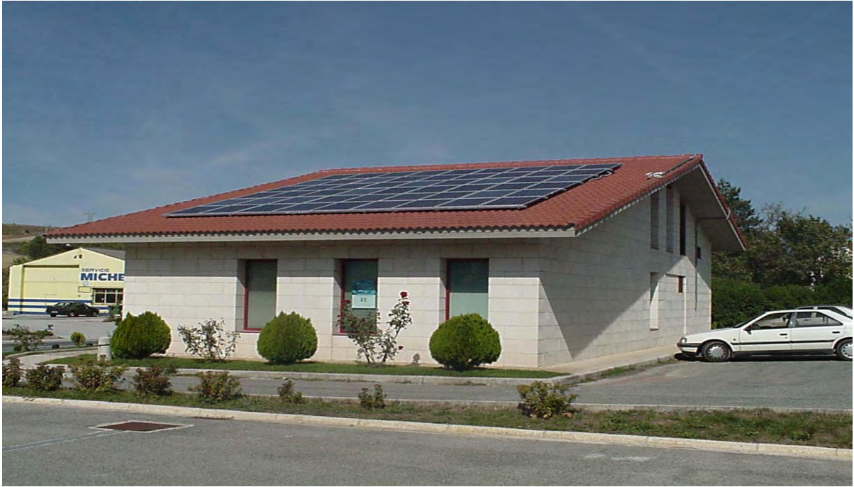
Foto 3. Sistema fotovoltaico sobre tejado inclinado.
