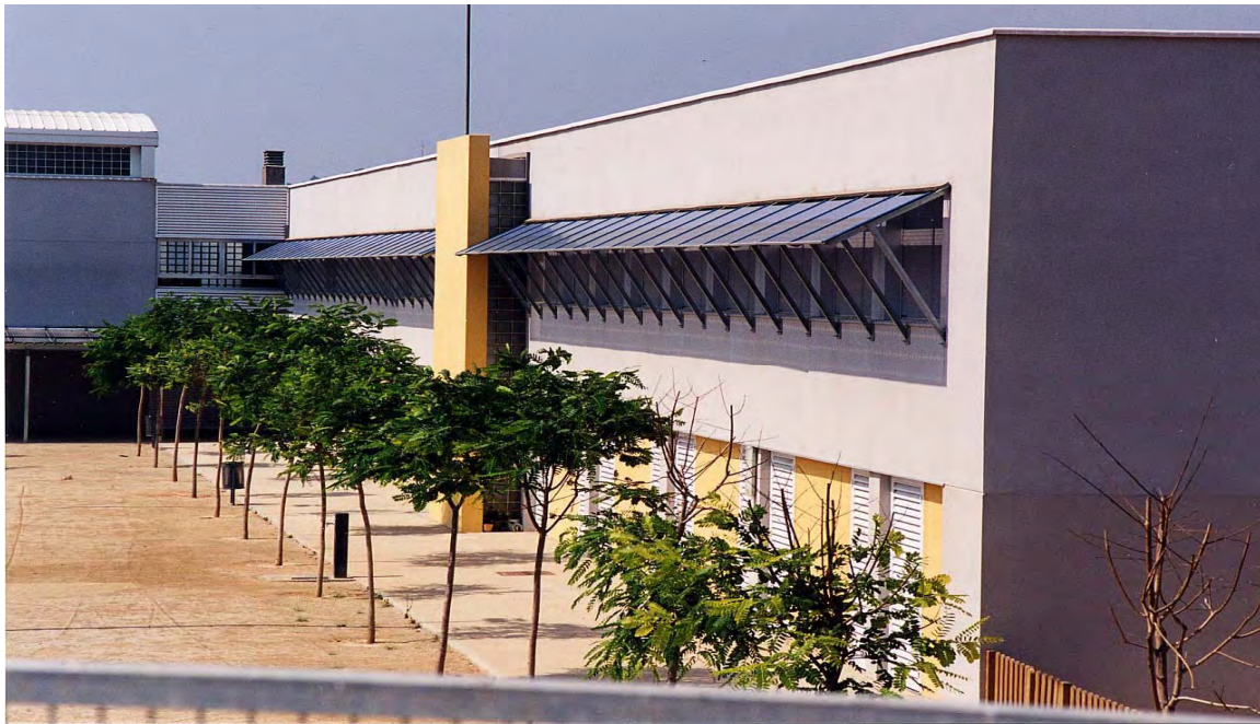
Foto 11. Instalación fotovoltaica integrada en parasoles.
