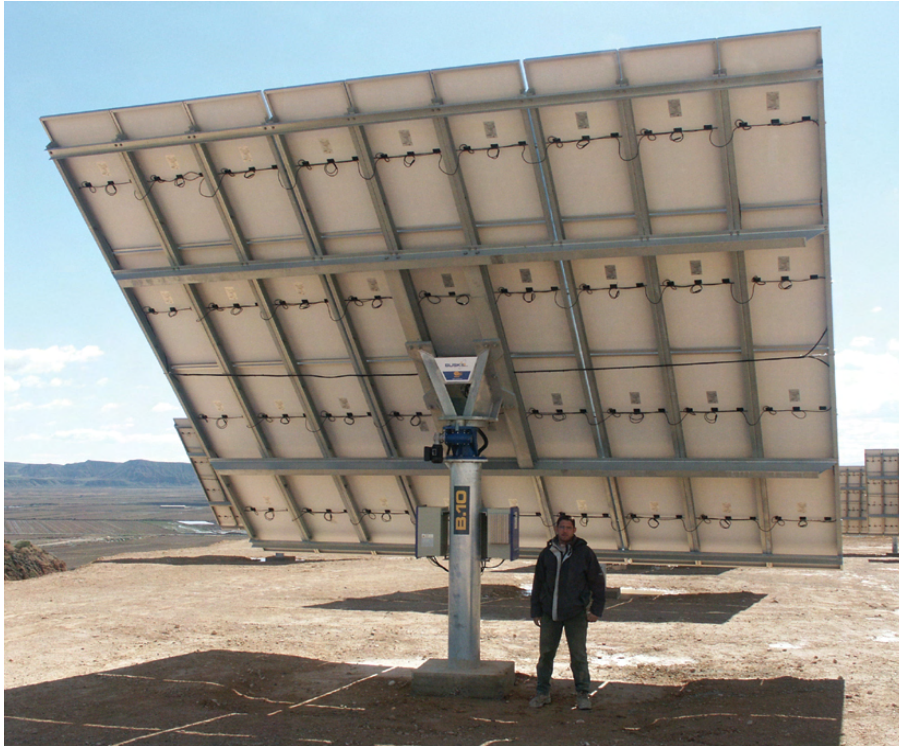
Foto 7. Instalación fotovoltaica sobre seguidor solar.
