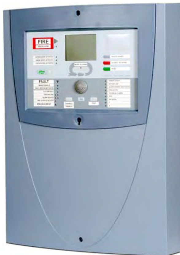
Figura 11. Central de Detección Automática de Incendios, FX.
