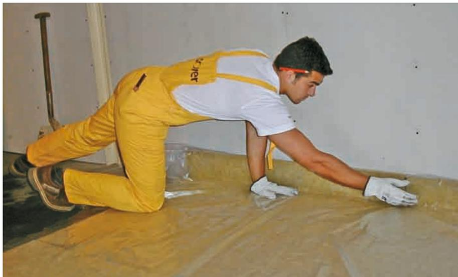
*La elasticidad del arena PF elimina la rigidez entre el forjado y el pavimento.*
