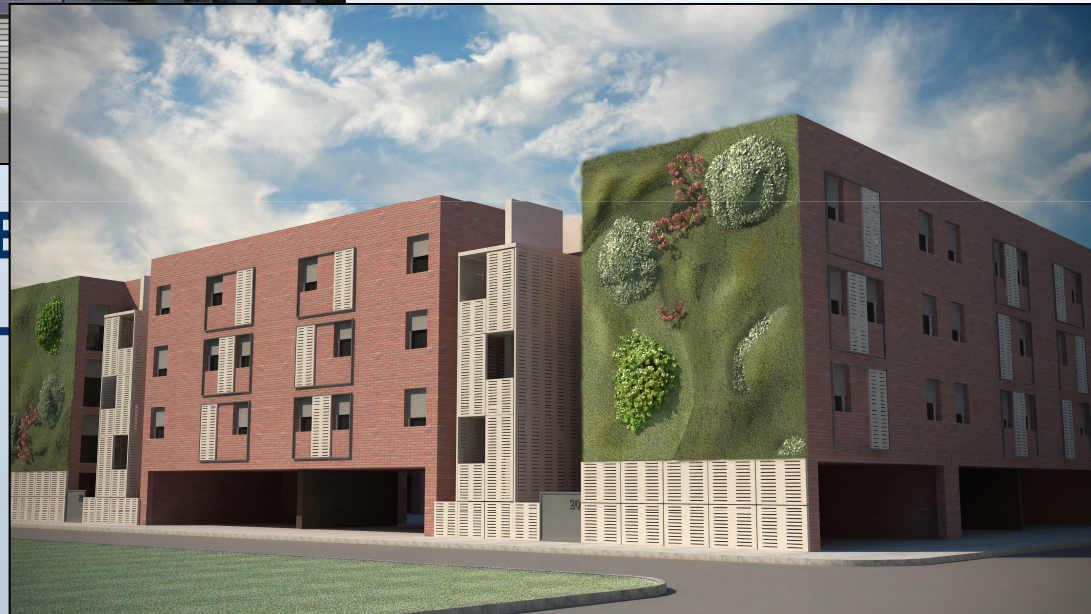
FACHADA CON FÁBRICA DE LADRILLO VISTO Y TESTEROS CON JARDÍN VERTICAL
