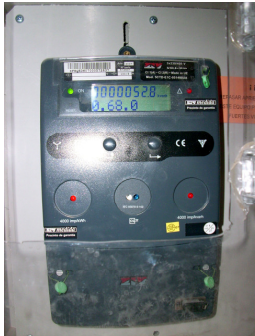
Contador obra tradicional
