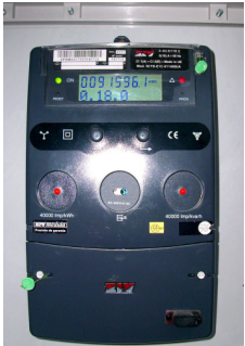
Contador obra industrializada
