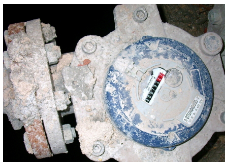
Contador obra industrializada
