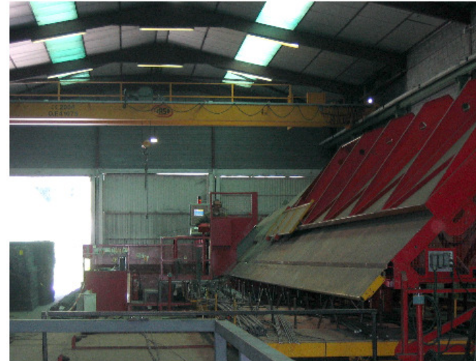
Mesa de encofrado 02
