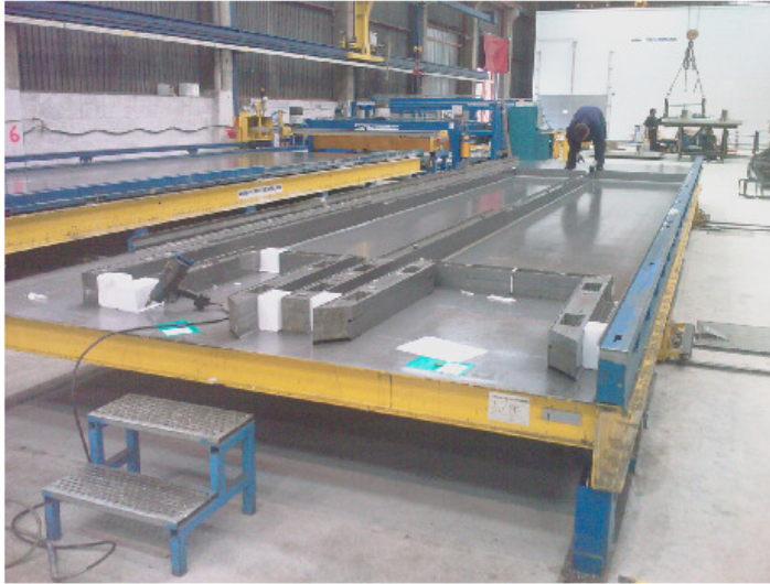
Mesa de paneles
