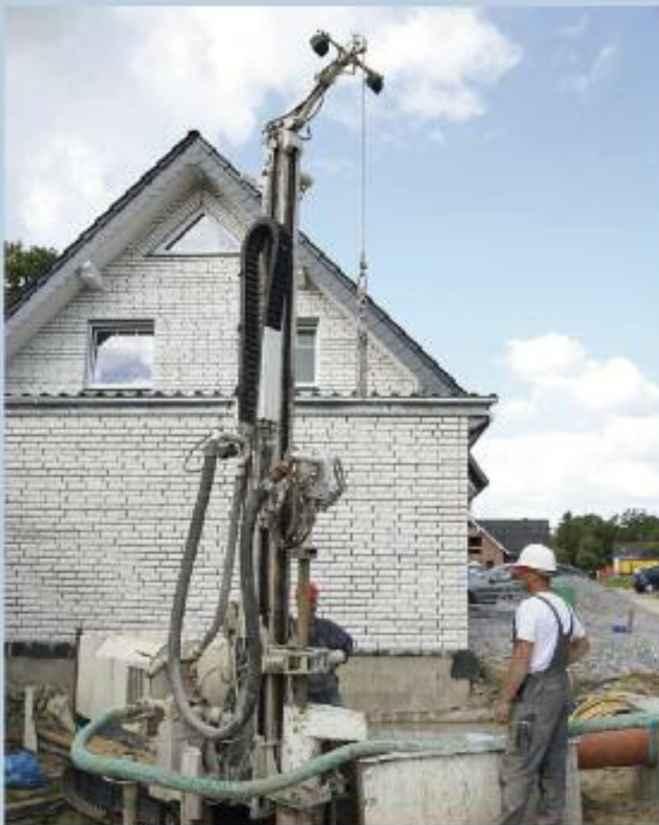
Perforación de sondas terrestres
