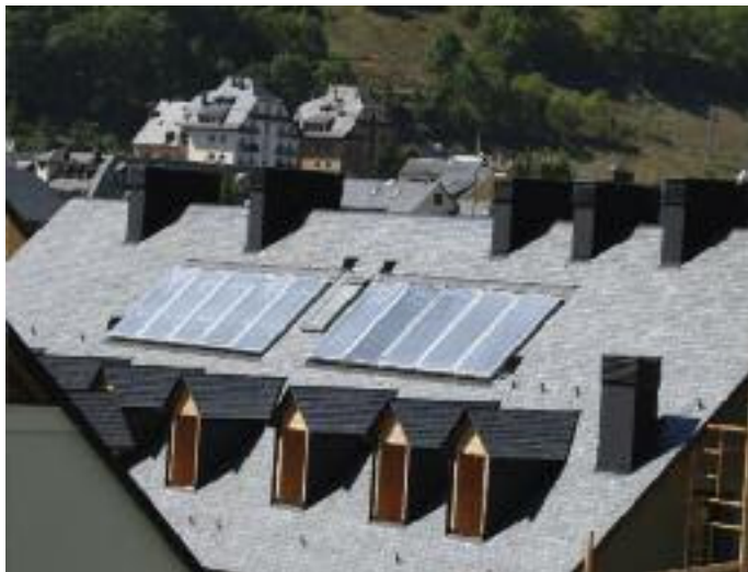
Ejemplo de instalación de colectores solares
