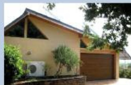
Bomba de calor de aire o agua montada en el exterior
