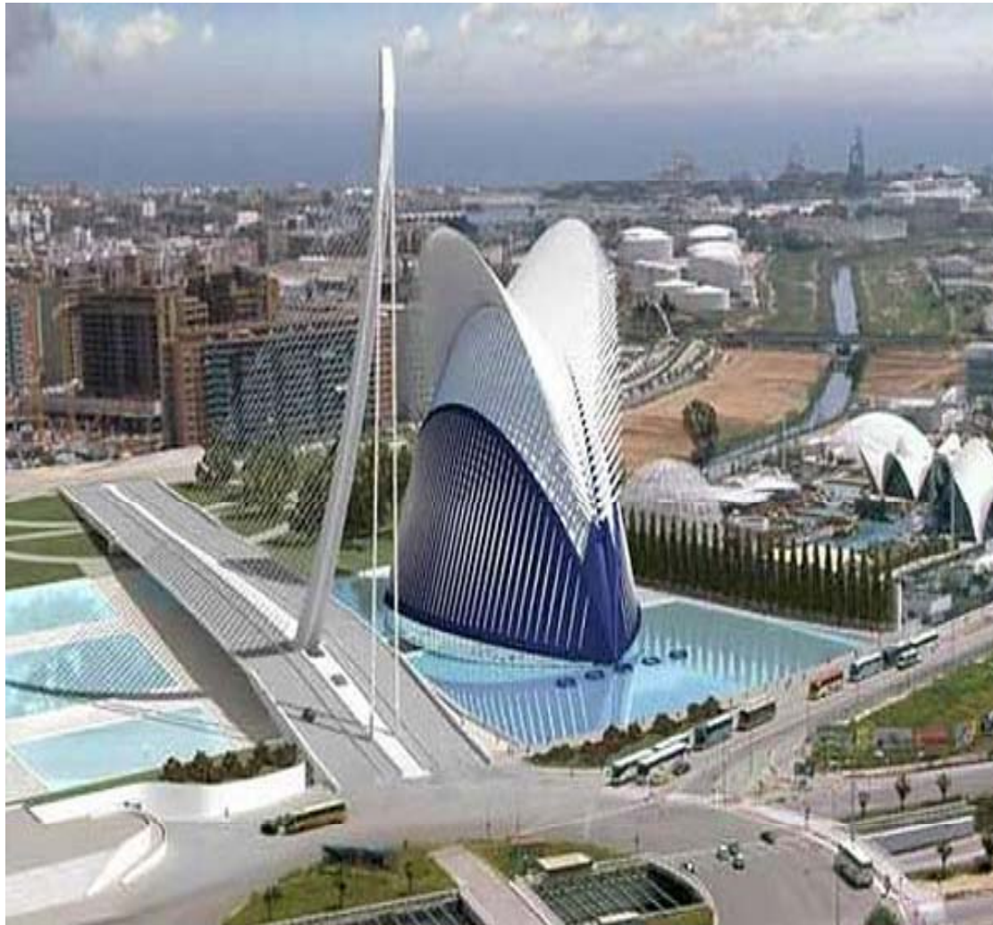
Edificio Ágora en la Ciudad de las Ciencias de Valencia (España) 3.530 m 2
