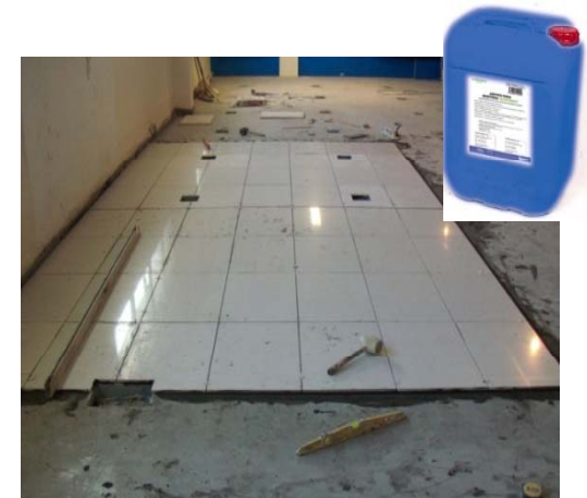
PASO 6: MORTERO Y PAVIMENTO
