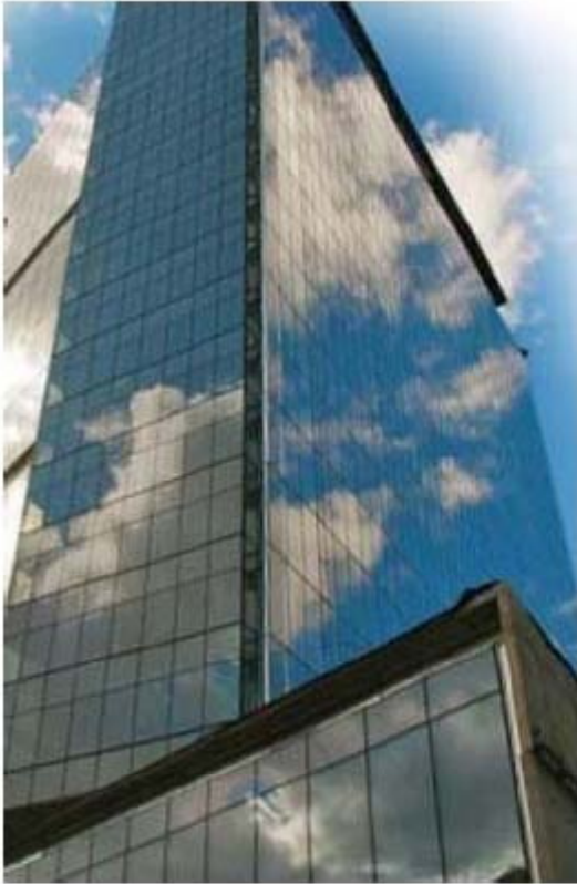
Edificio oficinas Manitoba (Canadá) Forjados Activos 64.000 m 2
