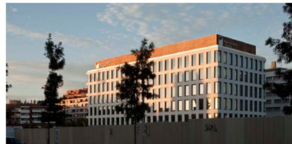
El edificio del Banc de Sang i Teixits de Catalunya (BST) está concebido como un contenedor flexible, eficiente, y saludable. Las fachadas de hormigón blanco y cuatro núcleos interiores, que incorporan los accesos y servicios, son la a la vez la estructura del edificio. No hay ningún pilar en el interior que dificulte la distribución de los espacios.
