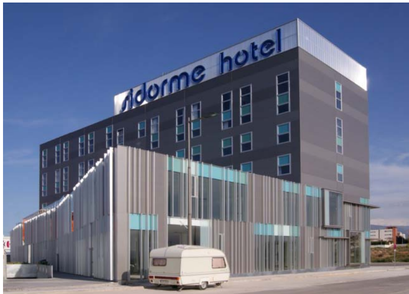
Ilustración 120. Fachadas sur. Hotel de Pulianas.
