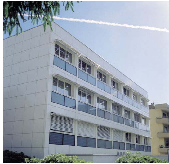
Colector solar como baranda solar térmica de Ingener.
