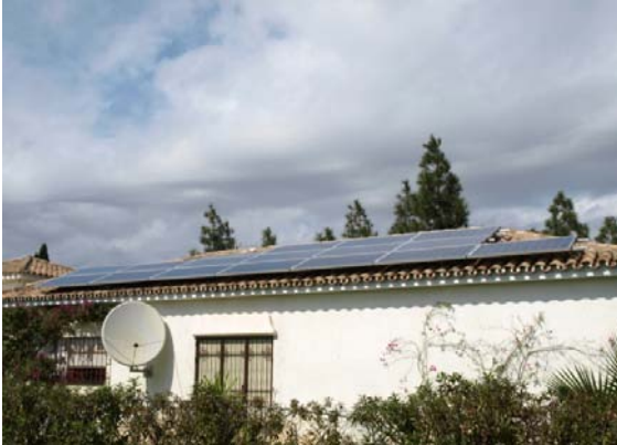
Instalación de SHP Europe
