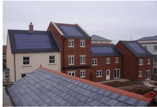
Tejados solares con tejas de Fangxing
