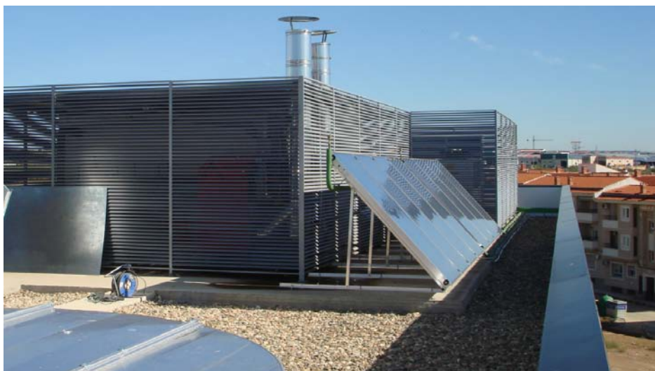
Ilustración 125. Instalación solar térmica. Centro de salud de Coria.
