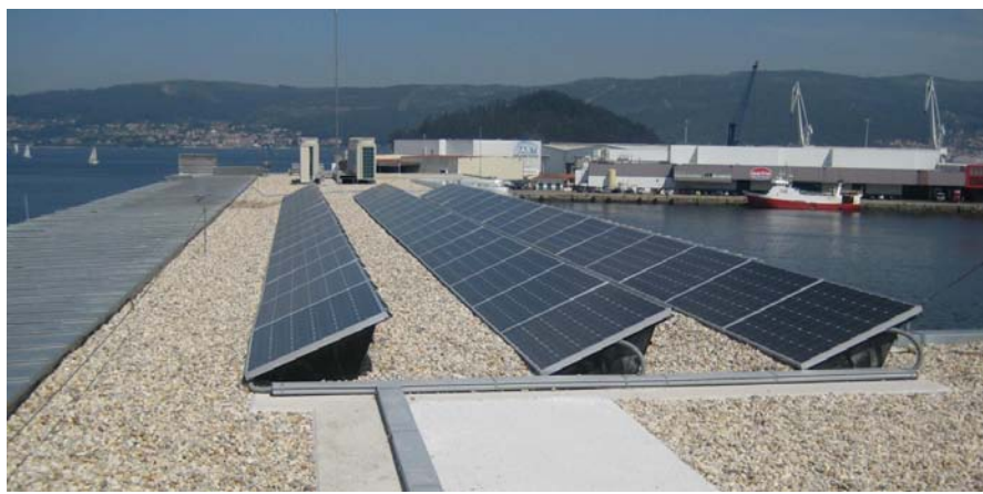
Ilustración 141. Paneles fotovoltaicos. Edificio administrativo de Marín.
