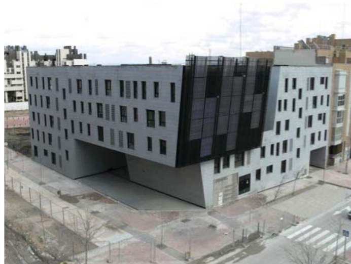
Ilustración 28. Tubos de vacío en la fachada del edificio Vallecas 48, del estudio de arquitectura AuriensArquitectura.
