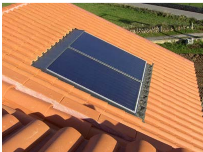
Instalación de Ansoltec.
