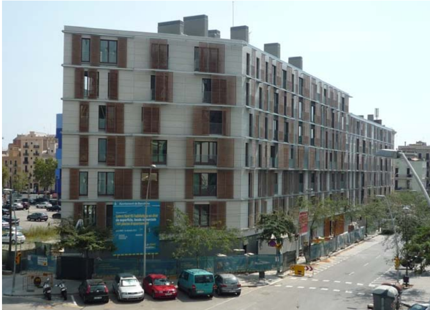
Ilustración 94. Fachadas oeste y suroeste. Bloque de viviendas en el 22@.
