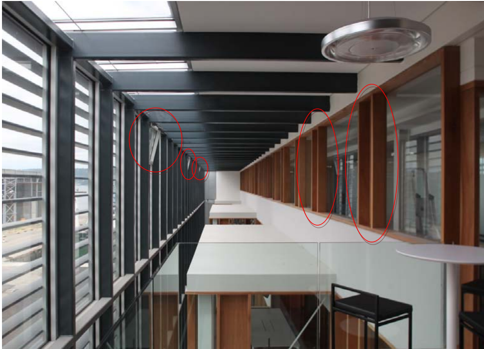
Ilustración 136. Aperturas para ventilación exteriores e interiores. Edificio administrativo de Marín.
