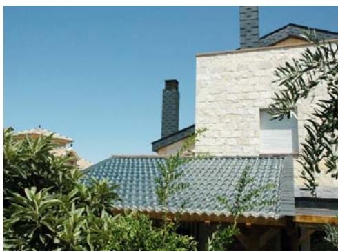
Tejado solar de SolTech Energy Mediterráneo.
