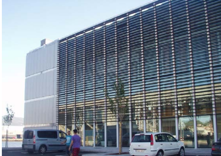
Ilustración 131. Fachada suroeste. Edificio administrativo de Marín.
