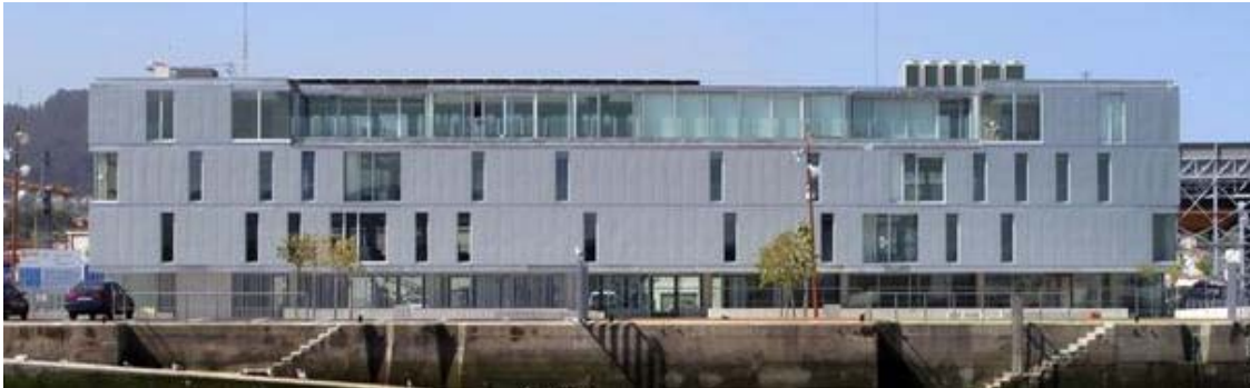
Ilustración 132. Fachada norte. Edificio administrativo de Marín.
