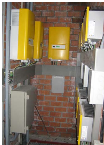
Ilustración 142. Baterías. Edificio administrativo de Marín.
