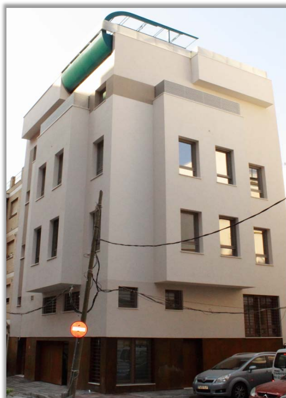
Ilustración 88. Fachadas este y norte. Edificio Barea.
