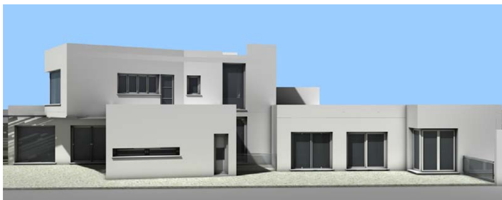
Ilustración 100. Fachada sureste. Vivienda unifamiliar de Loja.
