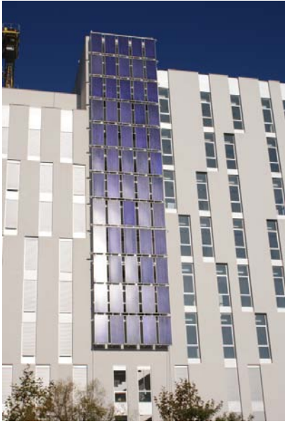
Fachada solar térmica de Forestam.
