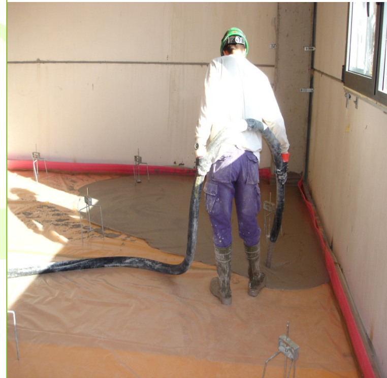
APLICACIÓN MORTERO SOBRE AISLAMIENTO TERMICO
