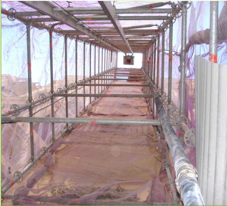
SUBIDA DE LA MANGUERA A OBRA
