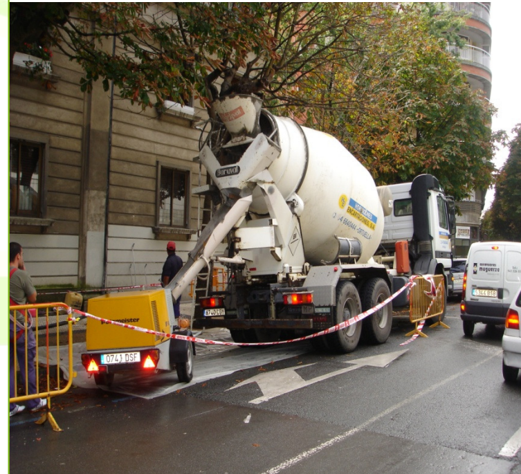
INICIO DEL BOMBEO A OBRA
