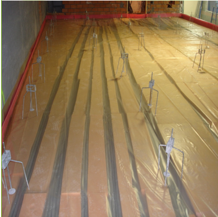
PASO DE INSTALACIONES CON AISLAMIENTO TERMICO
