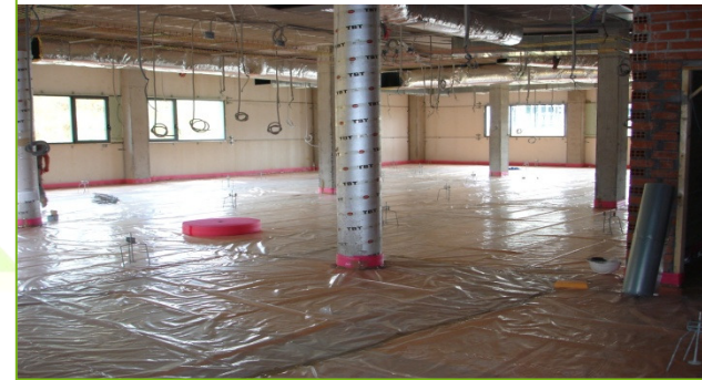
OBRA PREPARADA Y NIVELADA
