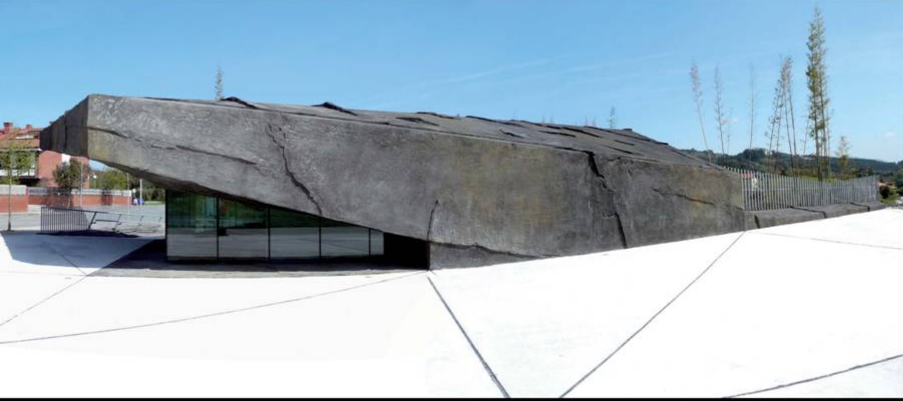
ESCUELA INFANTIL HAURRESKOLA URDULIZ 44 EFICIENCIA ENERGÉTICA Y SOSTENIBILIDAD: climatización radiante, reciclados y acabados 2012_10_10
