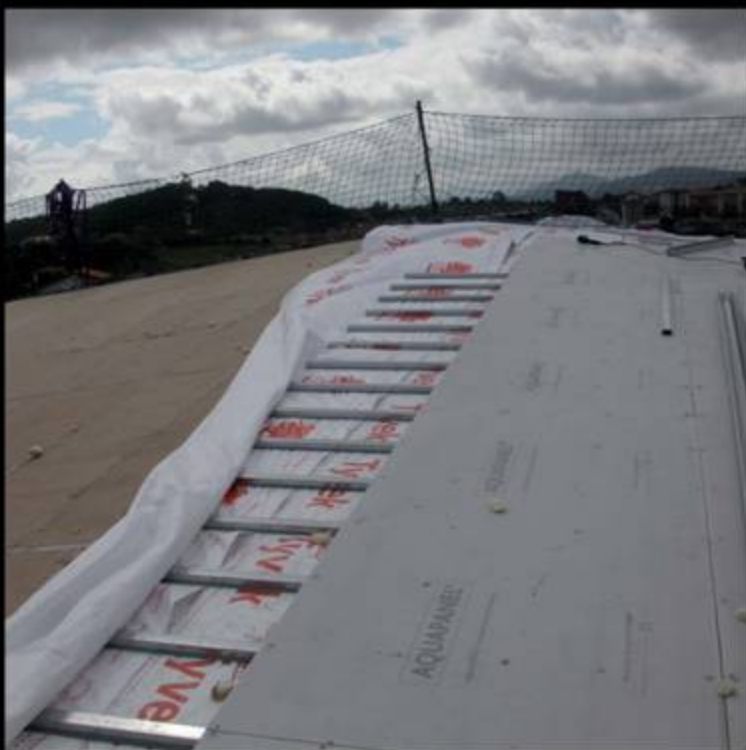
Revestimiento superior de la cubierta con paneles trasdosado AQUAPANEL
