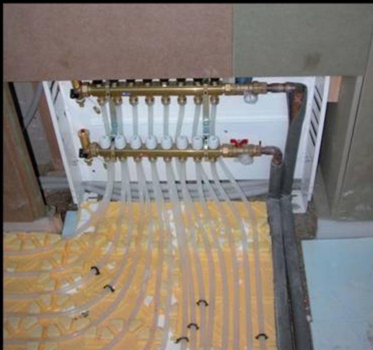
Instalación suelo radiante
