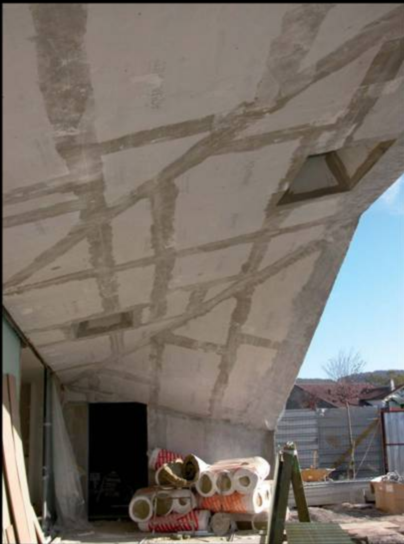
Revestimiento interior de la cubierta trasdosdo AQUAPANEL
