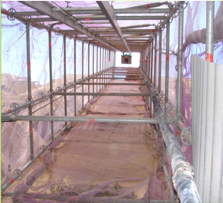
SUBIDA DE LA MANGUERA A OBRA
