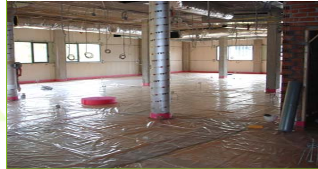
OBRA PREPARADA Y NIVELADA
