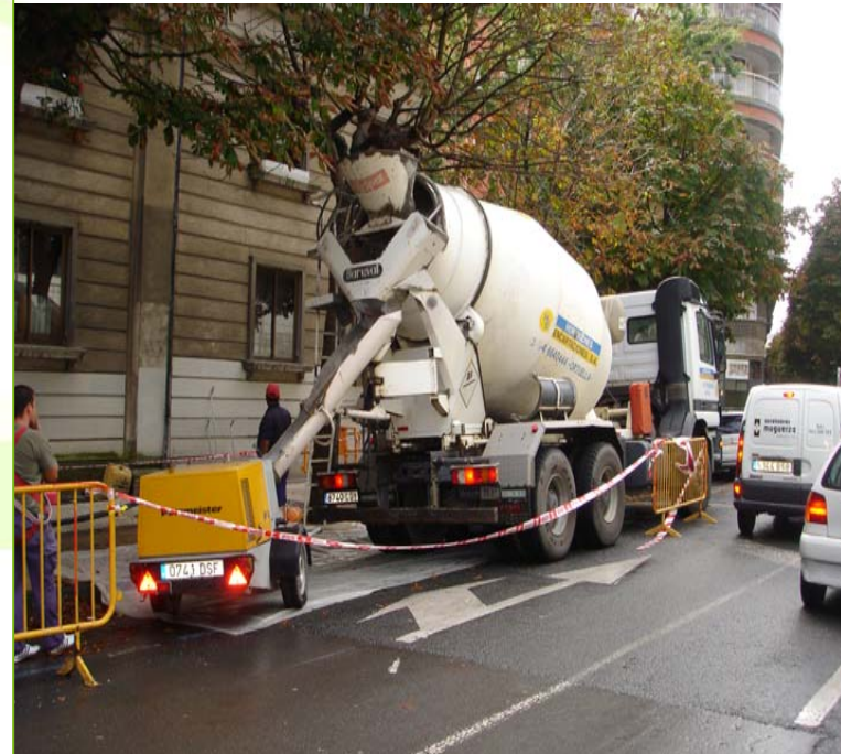
INICIO DEL BOMBEO A OBRA
