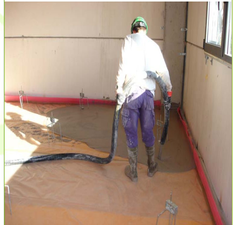
APLICACIÓN MORTERO SOBRE AISLAMIENTO TERMICO
