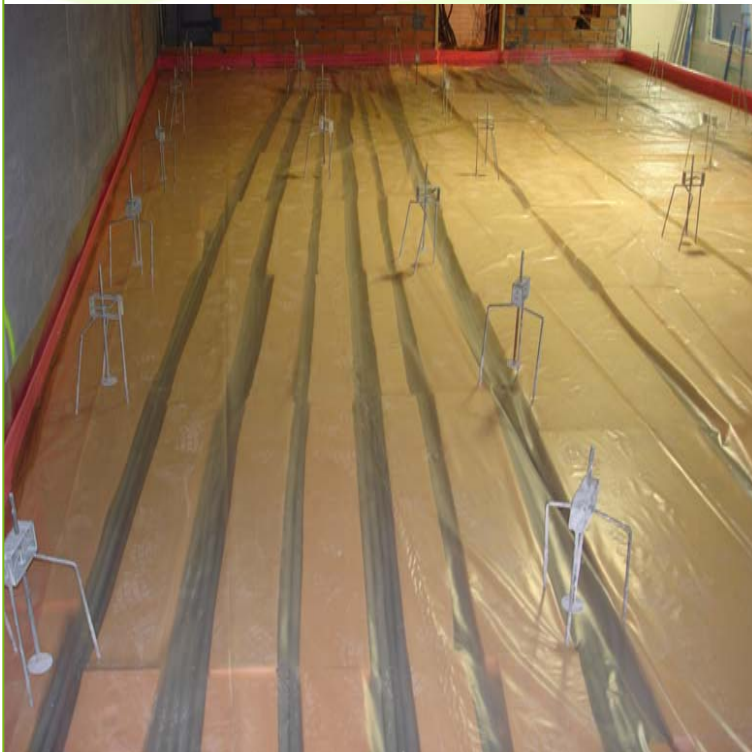
PASO DE INSTALACIONES CON AISLAMIENTO TERMICO
