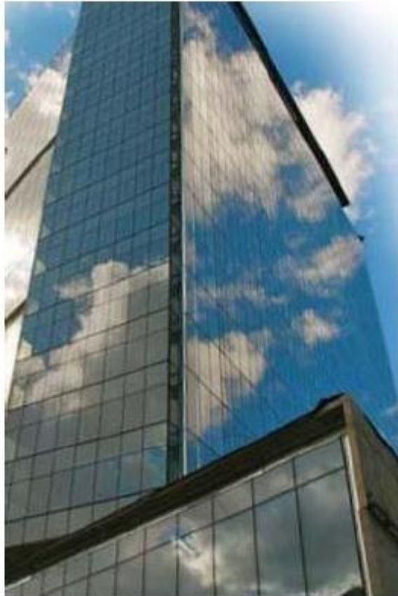
Edificio oficinas Manitoba (Canadá) Forjados Activos 64.000 m2
