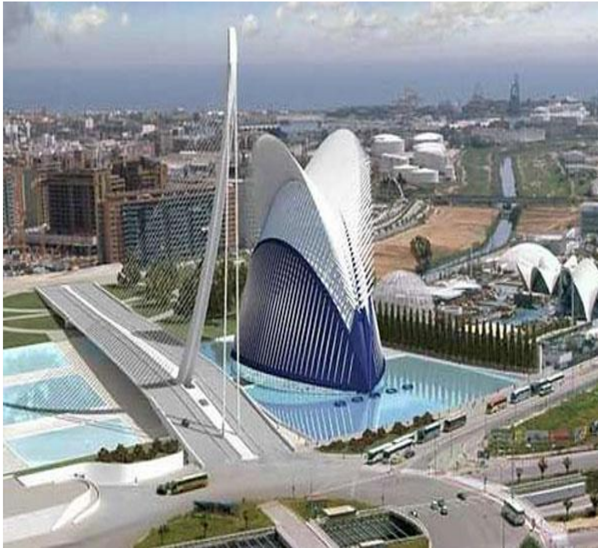
Edificio Ágora en la Ciudad de las Ciencias de Valencia (España) 3.530 m 2
