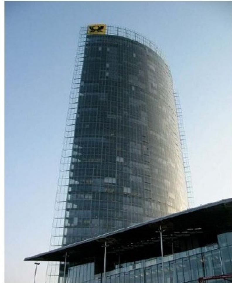
Edificio oficinas Deutsche Post (Alemania) Forjados Activos 60.000 m 2
