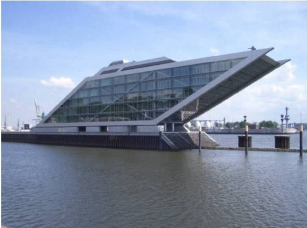
Edificio Dockland, Hamburgo (Alemania) Forjados Activos 18.000 m 2
