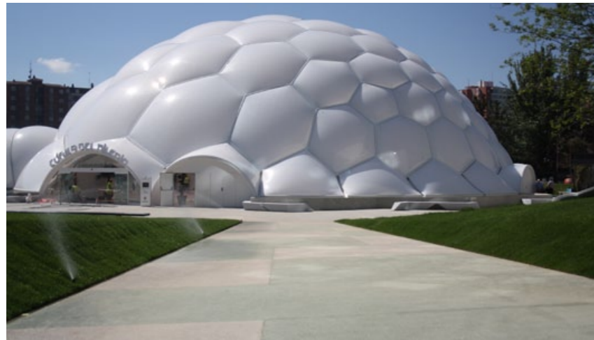
Plaza del Milenio de Valladolid, cuyo acceso ha sido íntegramente realizado en Artevia gris, hormigón de diseño creado por Lafarge
