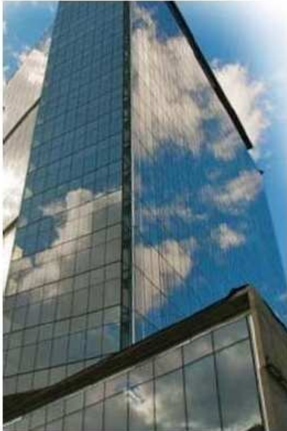
Edificio oficinas Manitoba (Canadá) Forjados Activos 64.000 m 2
