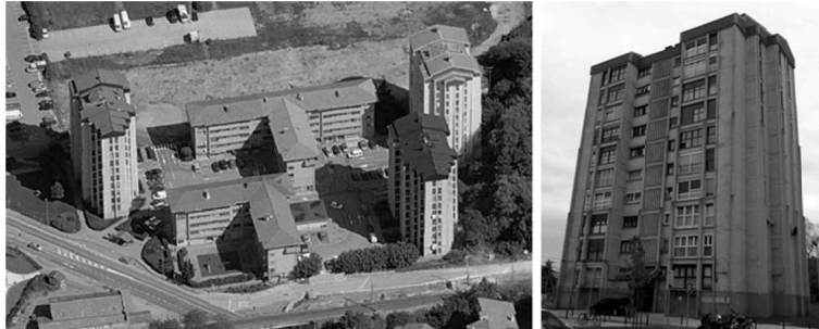
Figura 1. Barrio de Arragua. Situación e imagen del edificio.
