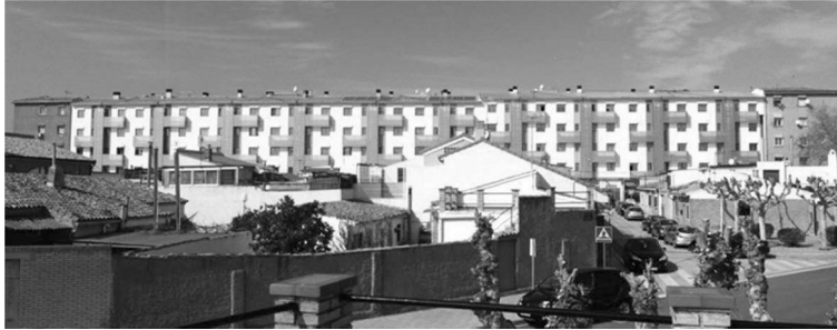
Figura 1. Fachada principal de los 100 pisos, rehabilitada.
