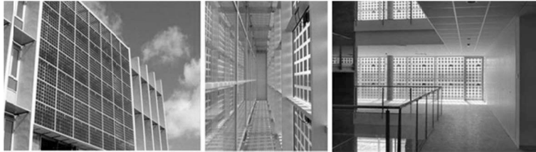
Figura 5. Diversas vistas del muro fotovoltaico de doble piel.
