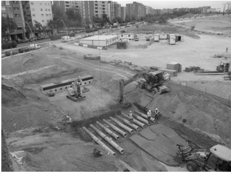
Figura 5. Acopio para colocación de tubos-canadienses.
