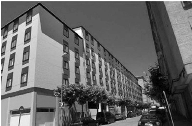
Figura 2. Bloques años 60 y 70 rehabilitados.
