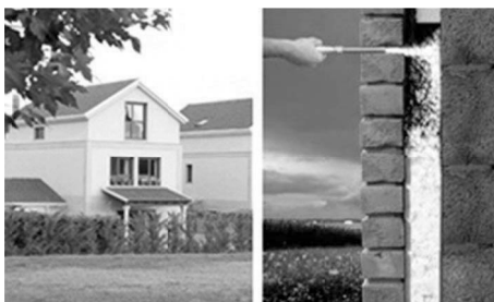
Figura 8. Insuflación cámara de aire muros cerramiento fachadas con Lana Mineral virgen.
