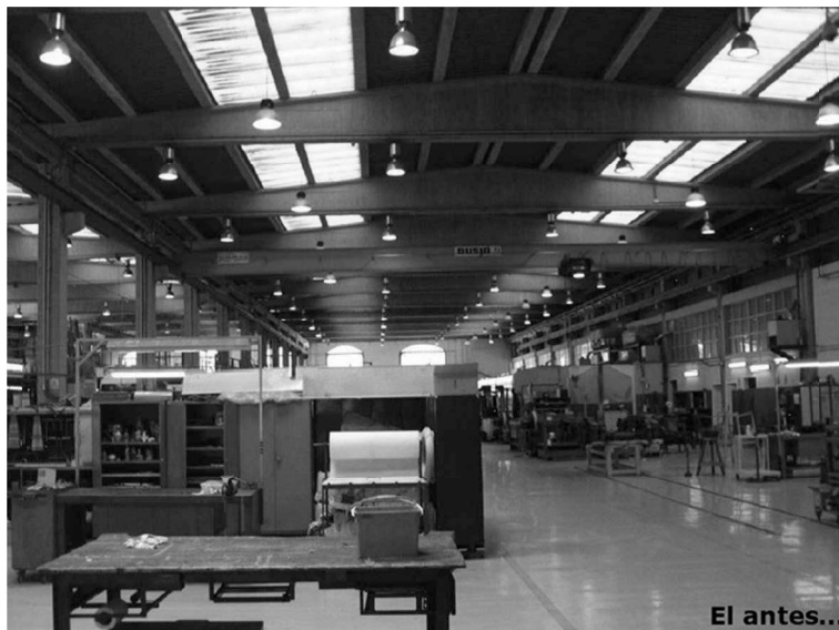
Figura 4. Antes de la intervención.
