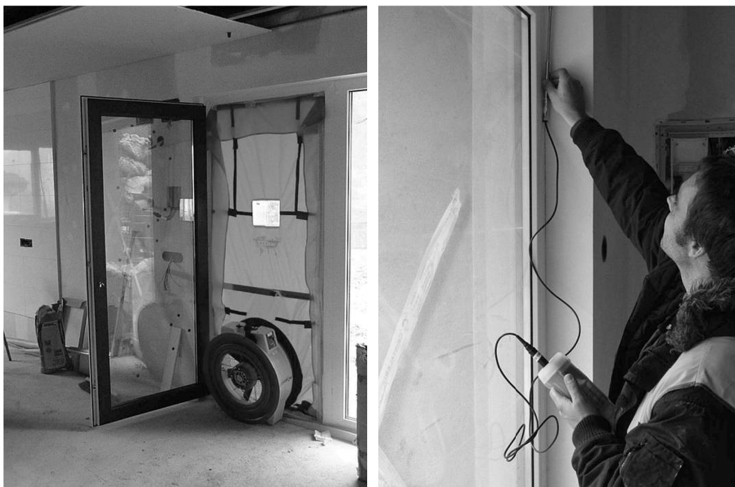
Figura 3. Instalaciones en la vivienda.
