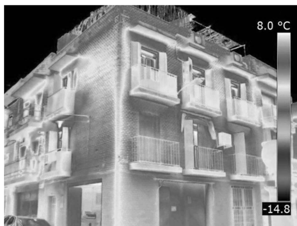
Figura 4. Imagen termográfica del edificio.
