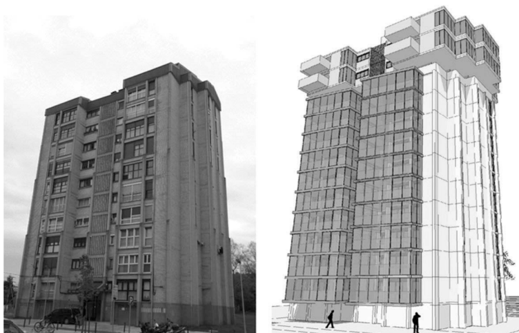
Figura 8. Imágenes del estado actual del edificio y de la propuesta.
