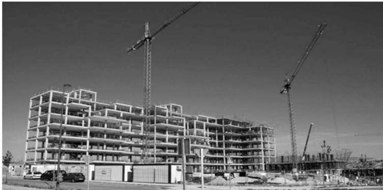
Figura 6. Construcción del edificio.
