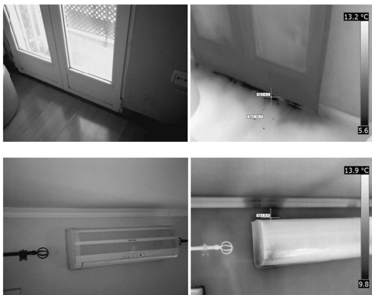
Figuras 5. Figuras visuales e infrarrojas de diferentes entradas de aire exterior.
