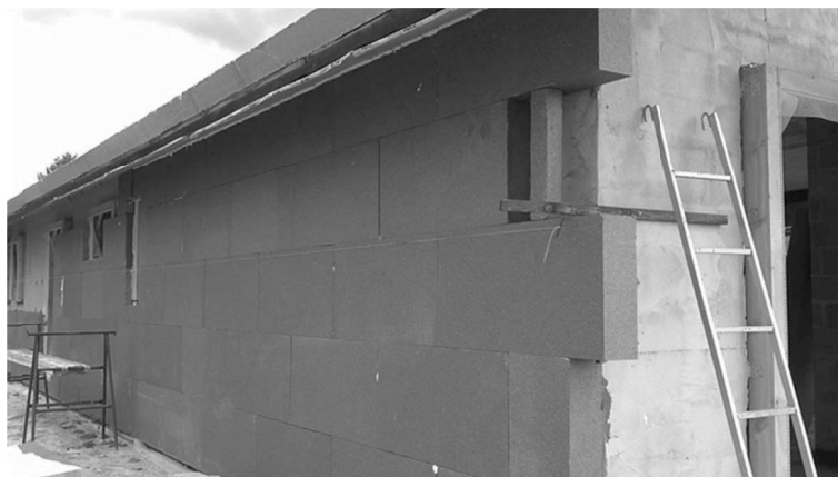
Figura 4. Fotografía de aislamiento por exterior de fachada. Jungitu (Álava).
