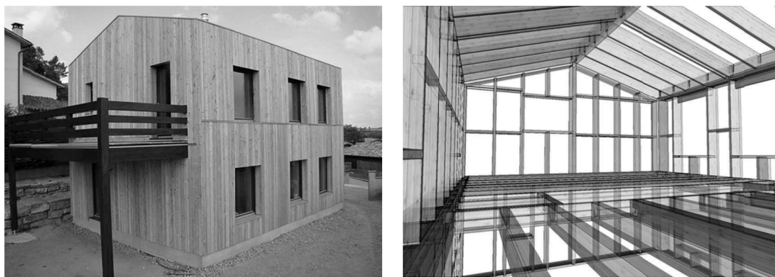
Figura 1. Larixhaus, edificio acabado y Visualización en 3D de la estructura del sistema constructivo Larixhaus.
