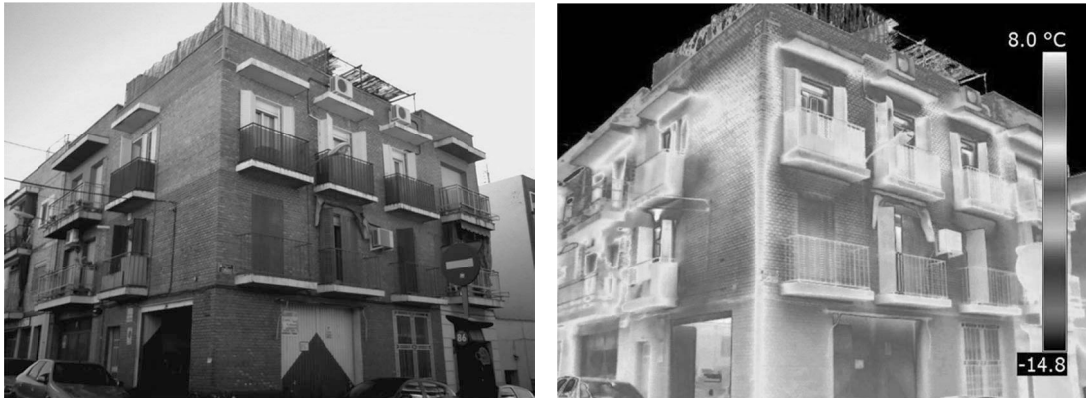
Figura 1. Vista general del edificio antes de la intervención y Termografía general del edificio, con la paleta de colores Arco iris, para mostrar los principales puentes térmicos.
