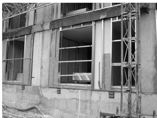
Figura 3. Fase de ejecución de la fachada ventilada (Fuente: archivo Patronato Municipal vivienda de Barcelona).
