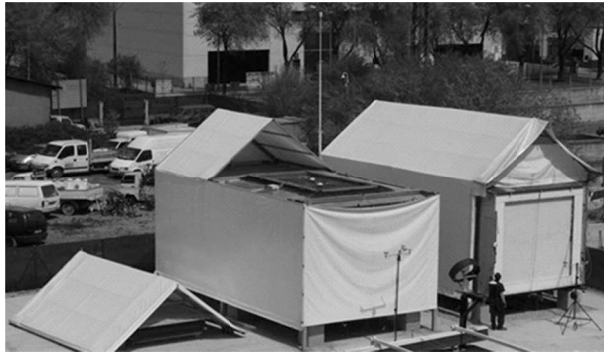
Figura 2. Zona de ensayos PASLINK en el LCCE. Izquierda: Techo de calibración para célula ILARGI, centro: Célula ILARGI ensayando una cubierta ajardinada, y derecha: célula EGUZKI ensayando una muestra de rehabilitación.
