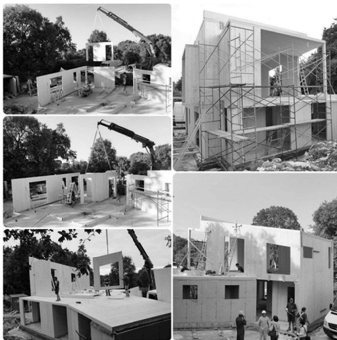
Figura 3. Montaje de la estructura de la casa EntreEncinas.
