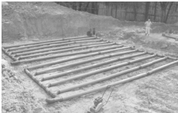
Figura 7. Intercambiador aire-tierra Awadukt thermo antimicrobiano.
