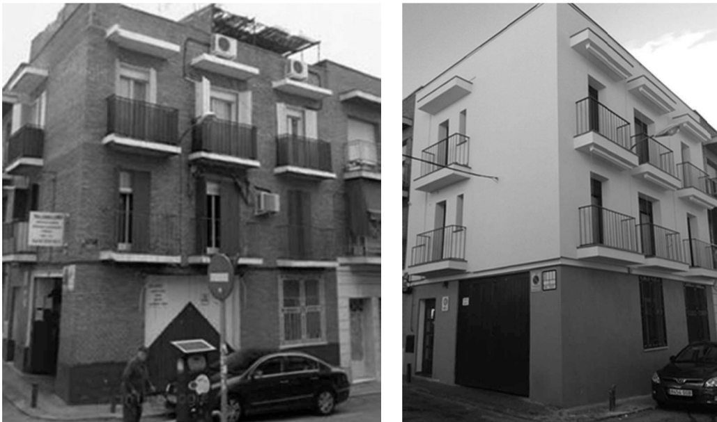
Figura 3. El edificio antes de las actuaciones y el edificio después de las actuaciones.
