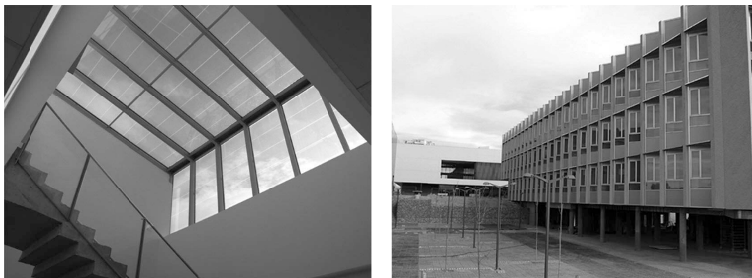
Figura 3. Izquierda: Lucernario Fotovoltaico transparente, edificio Lucia. Derecha: Edificio Lucia.
