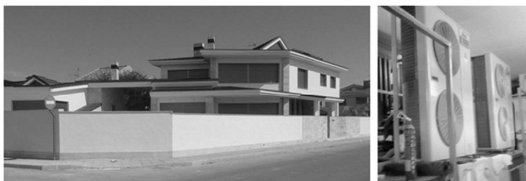
Figura 7. Fachada vivienda y bombas de calor aire-agua.
