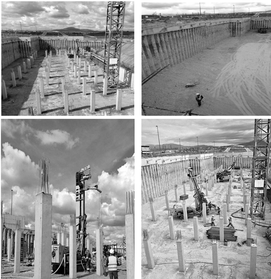
Figura 3. Construcción del edificio.
