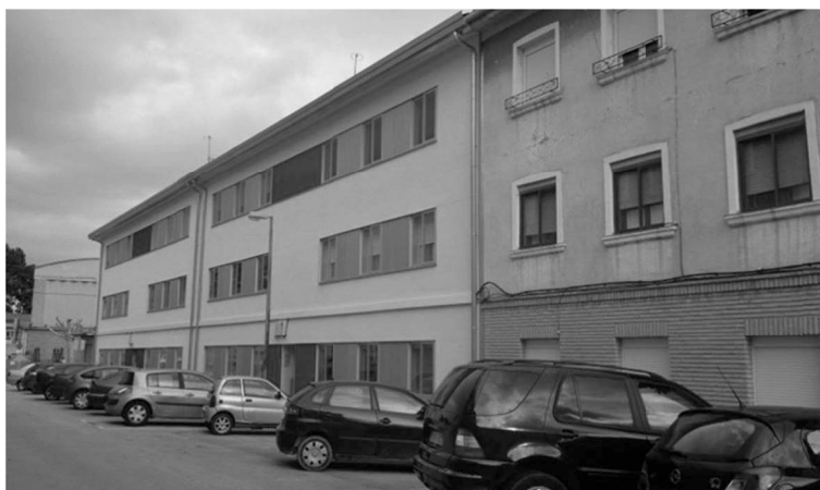
Figura 3. Bloque años 50, rehabilitado.
