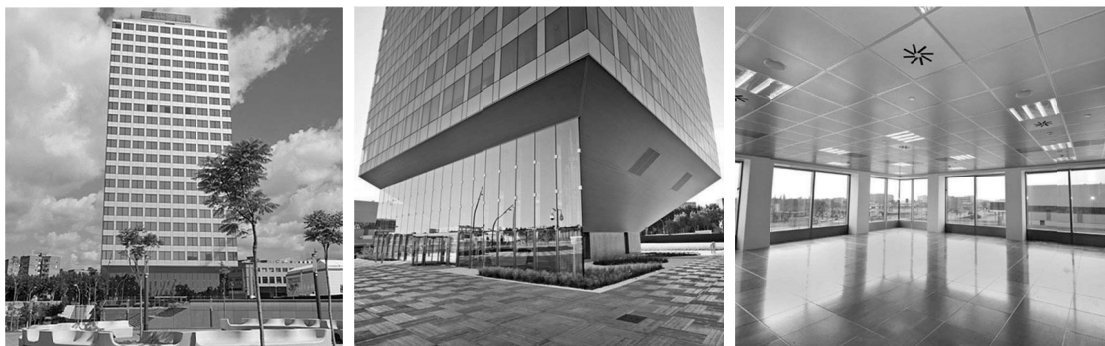
Figura 1. Edificio Torre Auditori de Porta Firal de Iberdrola. Izquierda: Exterior Edificio. Centro: Eliminación del anillo perimetral en Planta Baja. Derecha: Oficina tipo dentro del edificio.
