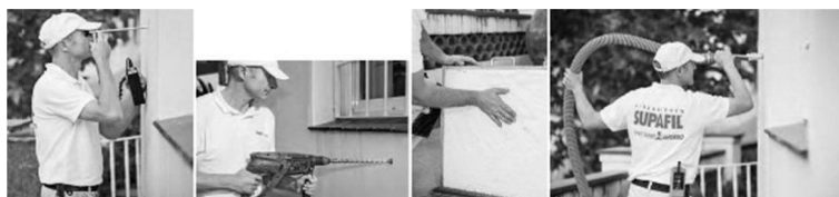
Figura 4. Proceso rehabilitación energética fachadas mediante insuflación mecánica de Lana Mineral: inspección cavidades, perforación puntos de insuflación, muestra material aislante, insuflado cámaras de aire.
