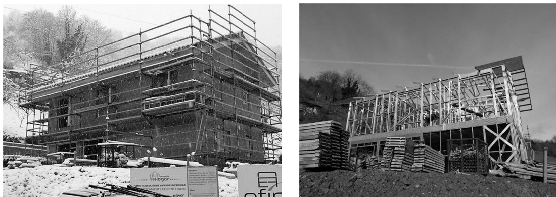
Figura 2. Construcción de la vivienda.
