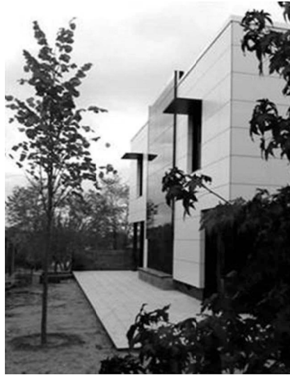
Figura 5. Muro Trombe controlado con Domintell.
