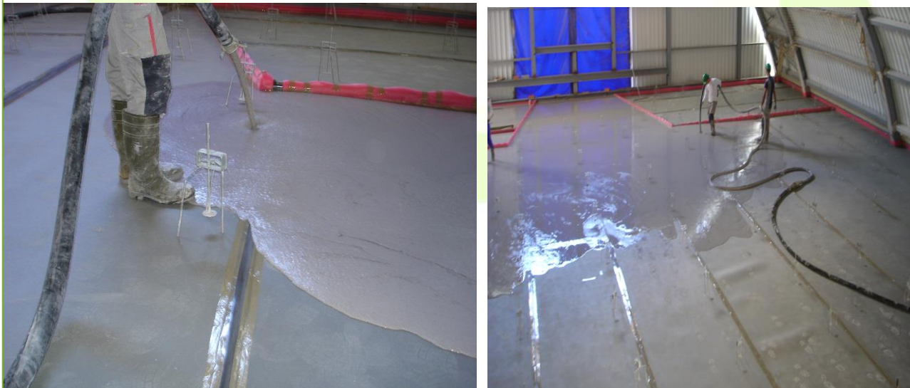
APLICACIÓN DEL MORTERO
