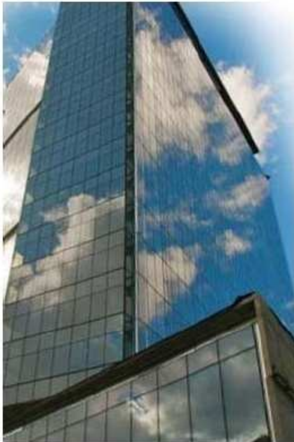
Edificio oficinas Manitoba (Canadá) Forjados Activos 64.000 m 2
