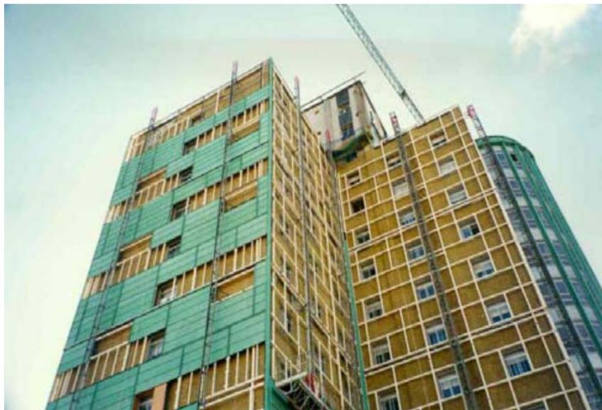
Figura 54.- Colocación fachada ventilada con aislamiento por el exterior
