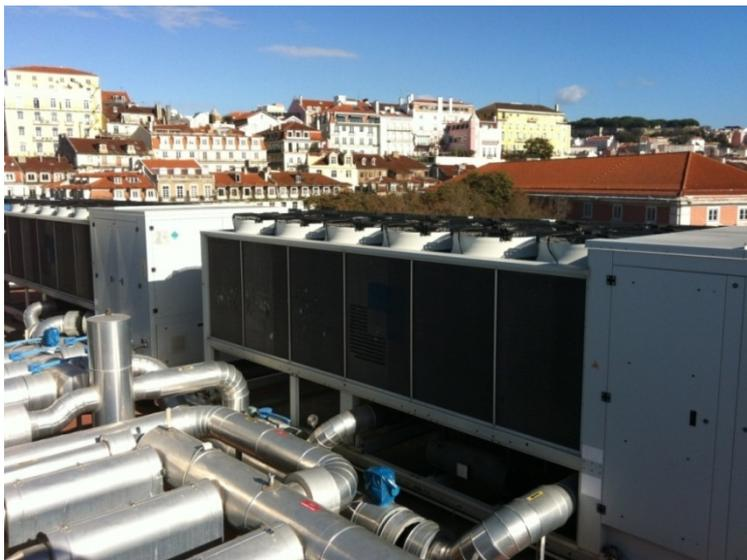
Figura 88.- Bomba de calor aire-agua Climaveneta ERACS-Q 2422/SL
