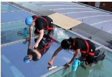
Figura 71.- Colocación de vinilo de control solar en ventana existente
