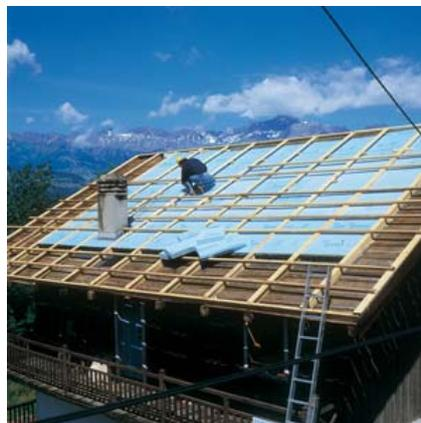
**Figura 58.-** Colocación de aislamiento de cubierta por el exterior
