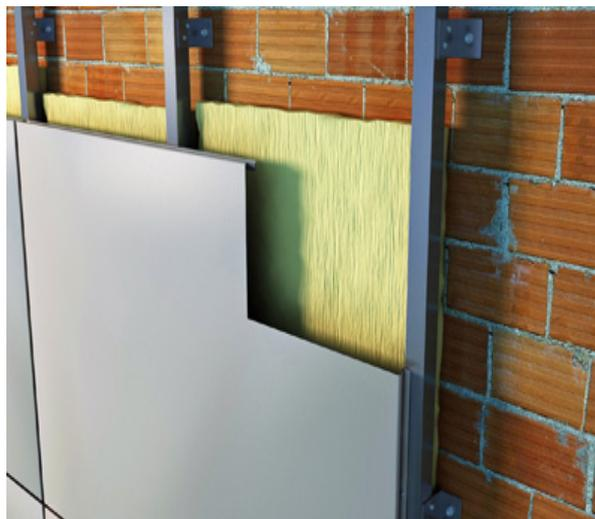
Figura 53.- Colocación fachada ventilada con aislamiento por el exterior
