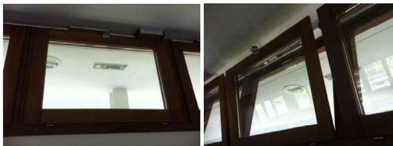
Figura 72.- Ventanas con dispositivos automáticos de ventilación natural
