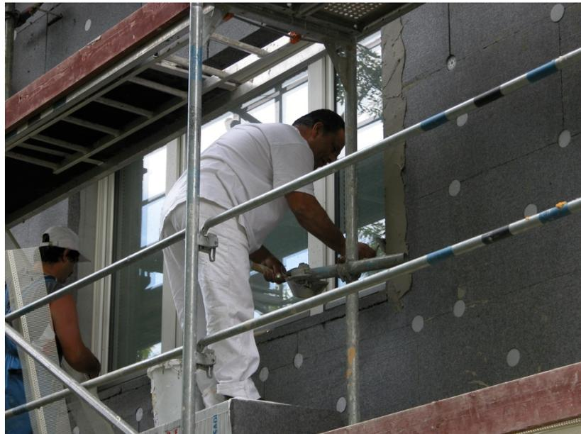
Figura 52.- Colocación de sistema SATE en edificios de viviendas
