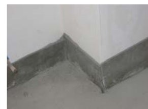
Detalle de encuentro de losa mortero con paredes, mal y bien ejecutado
