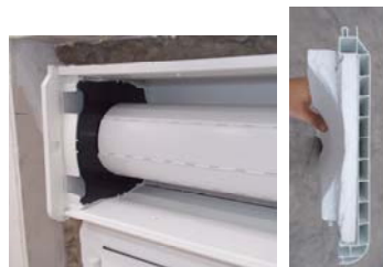
Ejemplo de una caja de persiana abierta y tapa con EPS insertado
