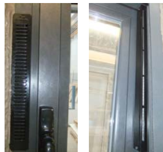
Ejemplo de un aireador colocado en perfilería de ventana (cara interior y exterior)
