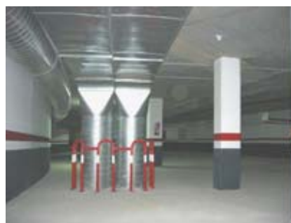
Ventilación forzada Garajes
