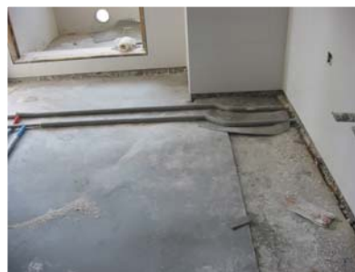
Proceso colocación material anti-impacto
