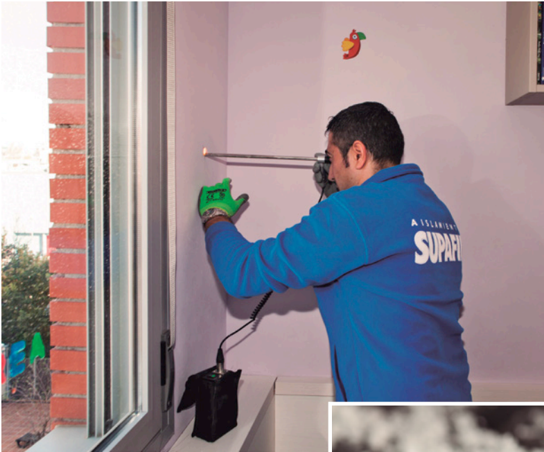
Figura 5. Inspección de la cámara de aire por el interior.
