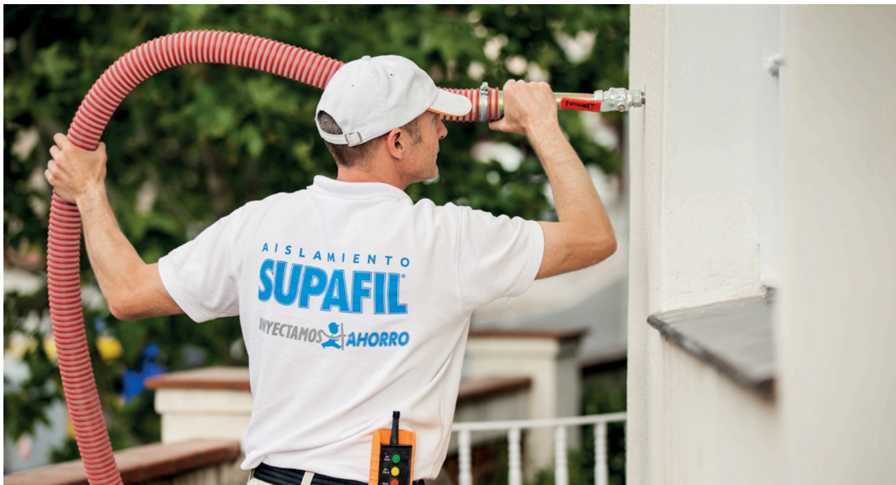
Figura 10. Insuflación con Supafil.
