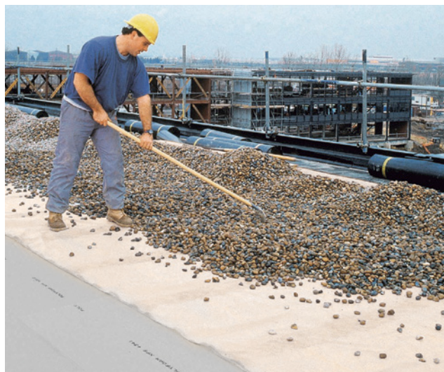
Figura 6. Rehabilitación de cubierta plana con Polyfoam.
