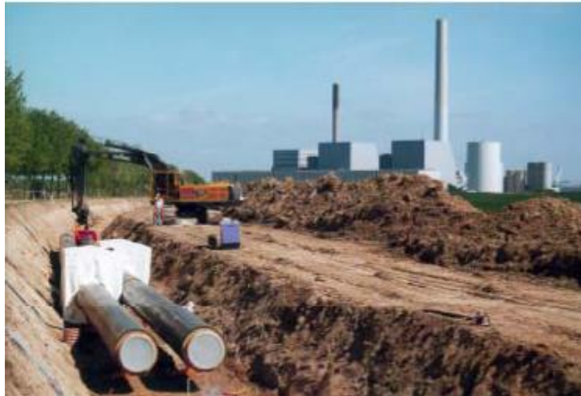
Ilustración 17. Instalación del trazado de transmisión de fluido térmico
