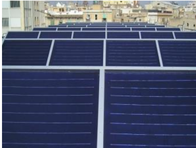
Ilustración 19. Captadores planos selectivos con cubierta antirreflectante en instalación de climatización solar. Edificio Peracamps, Barcelona. Fuente: Aiguasol
