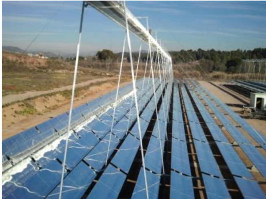
Ilustración 30. Instalación de 3.000m 2 de LFC en MAFRICA
