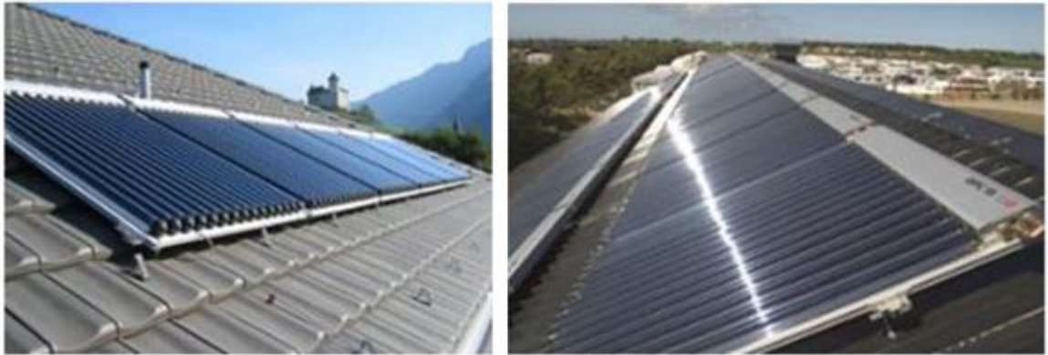
Ilustración 26. Instalación de tubos de vacío Fuente: SPF
