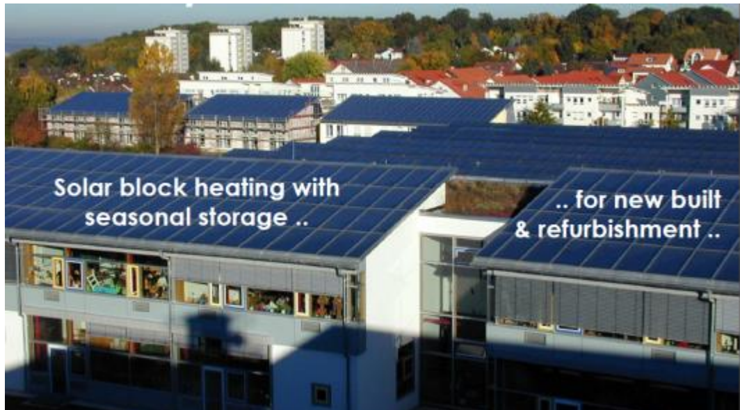
Ilustración 46. Sistema solar de Crailsheim. Fuente : Task 45 IEA SHC
