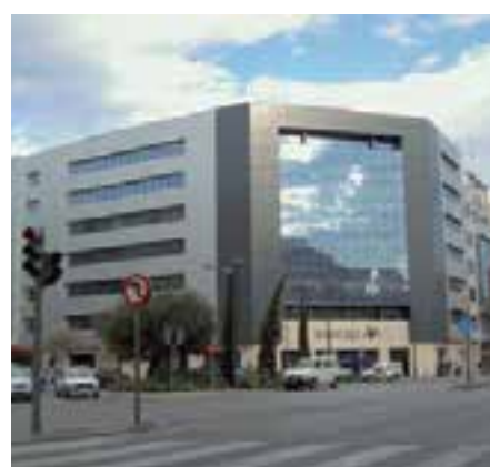
Edificio Centro de Cálculo Bancaja (Valencia)
