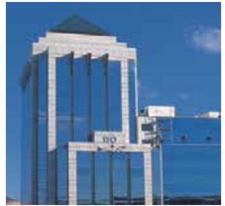
Edificio Castellana, 110 (Madrid)
