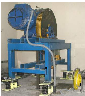
Fig 2. Amortiguación de maquinaria
