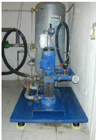
Fig 3. Ejemplo bancada inercia
