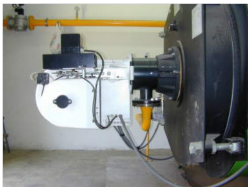
Fig 2. Quemador sin encapsulado
