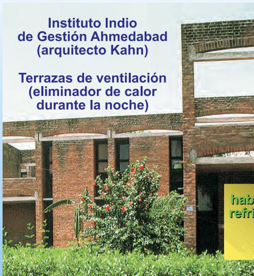
Renovación del aire y ventilación natural
