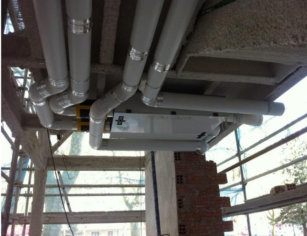
*Figura5. Puesta en obra Sistema Ventilación VCM DF.*
