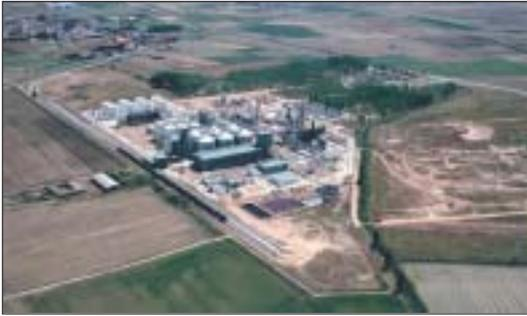
Esta planta es una de las primeras del mundo con esta capacidad de producir bioetanol a partir de biomasa, en particular utilizando paja de cereal, con tecnología de hidrólisis enzimática. La puesta en marcha con grano comenzó el 7 de abril de 2006 superando el test de prestaciones en el mes de julio.
