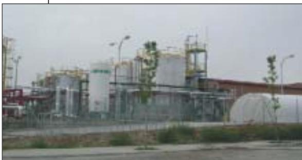
Este biodiésel se utiliza, mezclado con gasóleo, como combustible en autobuses públicos en Alcalá de Henares y Madrid. La planta dispone también de captadores solares térmicos para producir Agua Caliente Sanitaria (ACS) y agua para calefacción.
