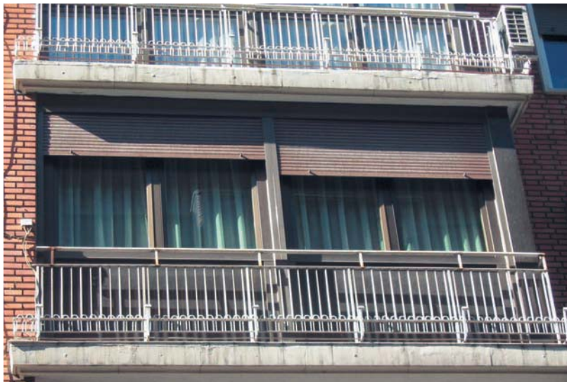
Foto 15. Carpintería exterior metálica de aluminio con doble acristalamiento bajo emisivo SGG CLIMALIT con PLANISTAR.
