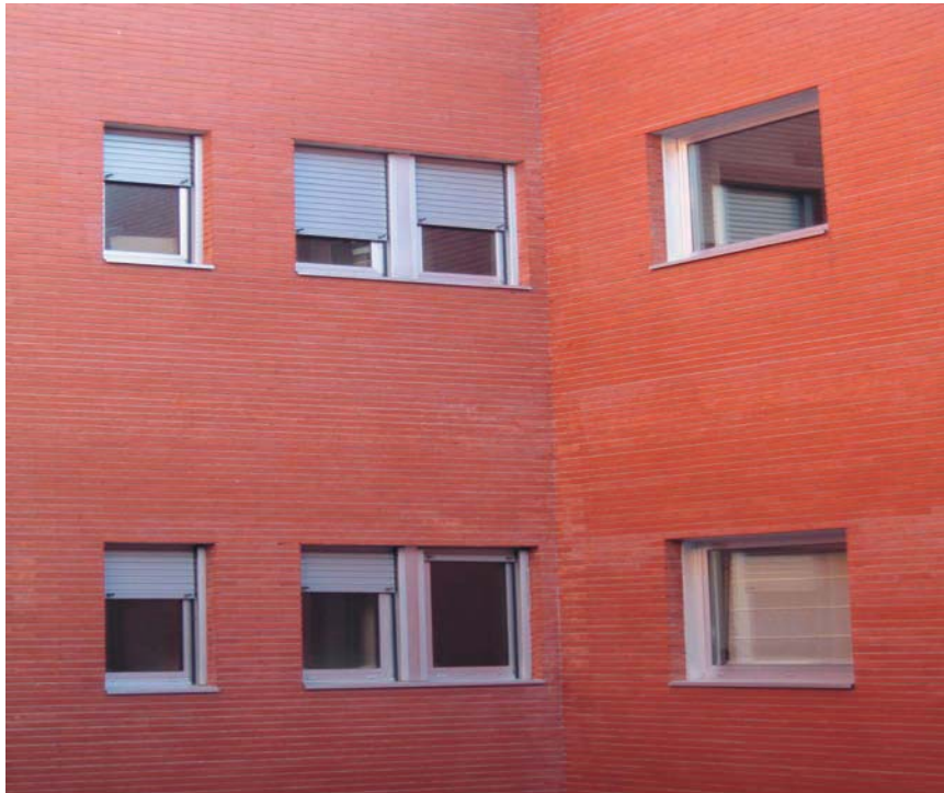
Foto 16. Carpintería metálica de aluminio RPT con acristalamiento banal.
