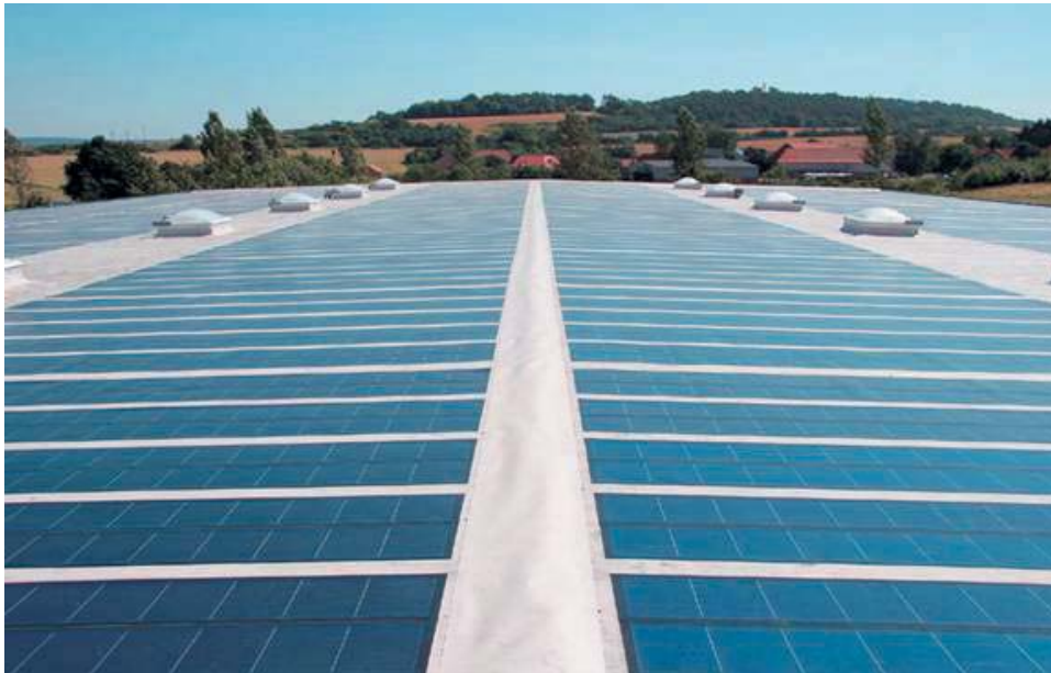
Foto 1. Cubierta solar terminada.
