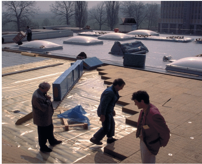
Foto 2. Cubiertas con fijación mecánica.
