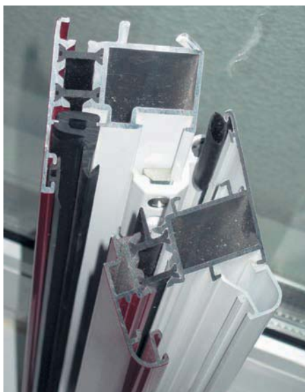
Foto 4. Carpintería metálica RPT. Sección característica.
