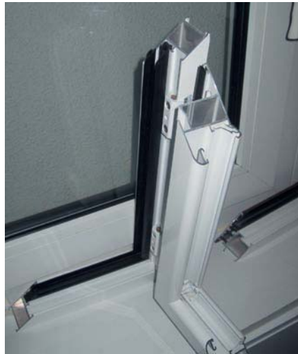
Foto 3. Carpintería metálica. Sección característica.
