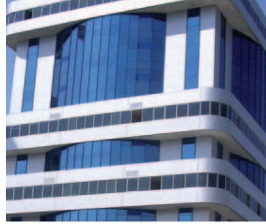
ISOLAR® GLAS es un acristalamiento aislante térmico y acústico, formado por dos o más lunas de vidrio separadas entre sí por un perfil de aluminio relleno de un tamiz molecular que absorbe la humedad residual, evitando la aparición de condensaciones en el interior de la cámara de aire así formada.
