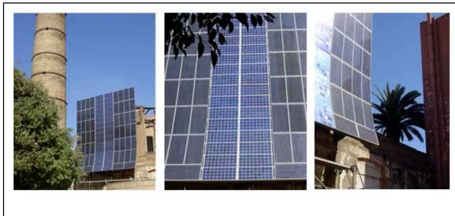
FIG 7 Instal·lacions fotovoltaiques a una de les façanes de l'edifici
