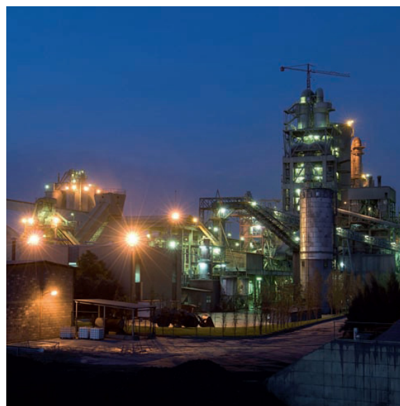
Fabrica de cemento de Alicante.
