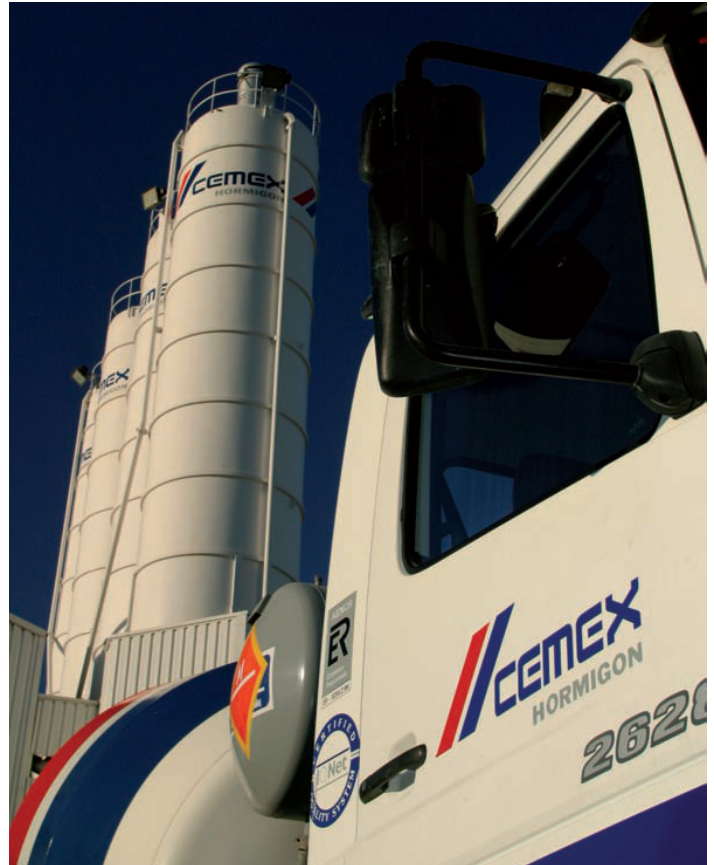
Planta de hormigón de Leganés (Madrid).
