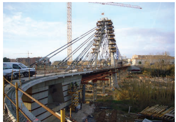
Puente de Manises en construcción.
