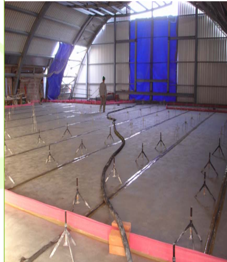
PREPARACION Y NIVELADO PARA LA APLICACIÓN DEL MORTERO
