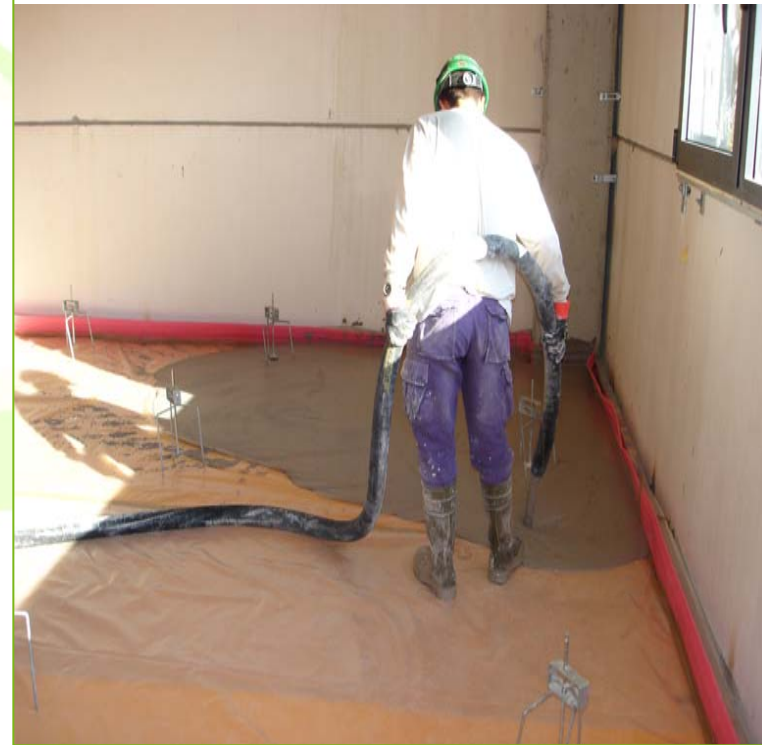
APLICACIÓN MORTERO SOBRE AISLAMIENTO TERMICO
