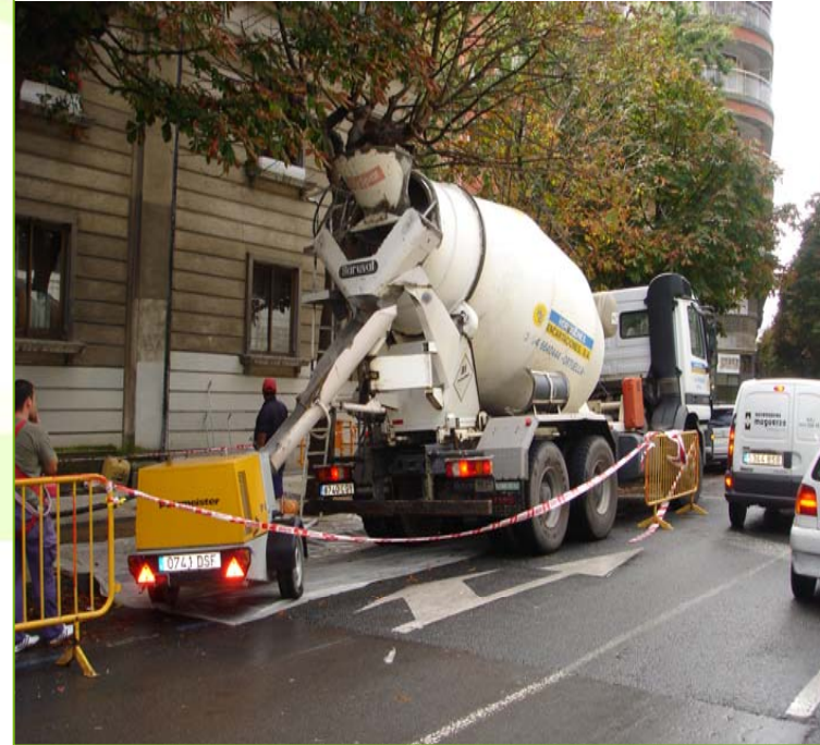
INICIO DEL BOMBEO A OBRA
