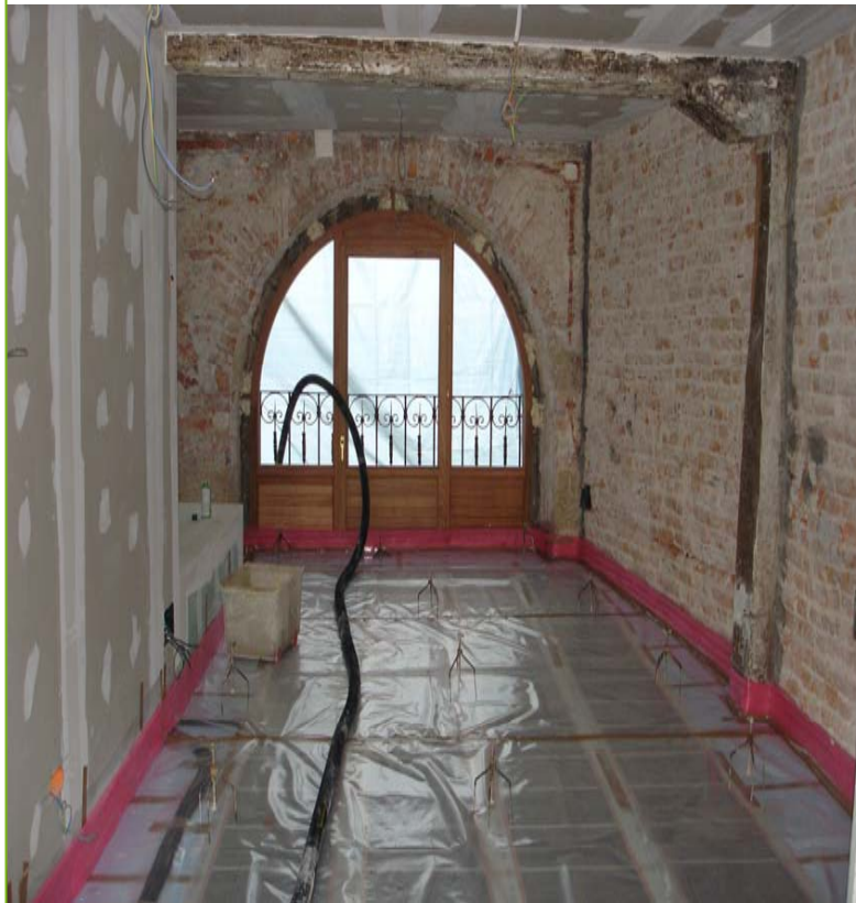
OBRA PREPARADA Y NIVELADA
