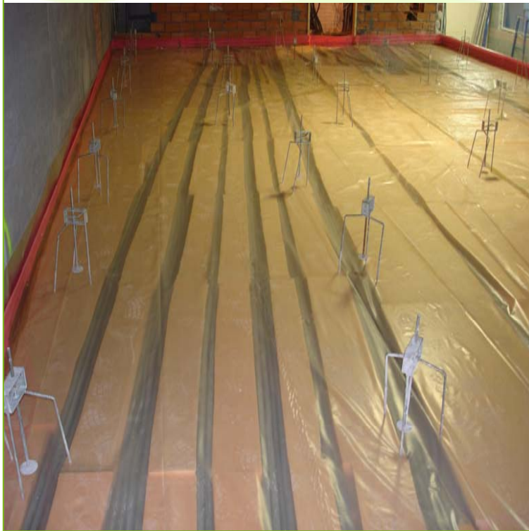
PASO DE INSTALACIONES CON AISLAMIENTO TERMICO
