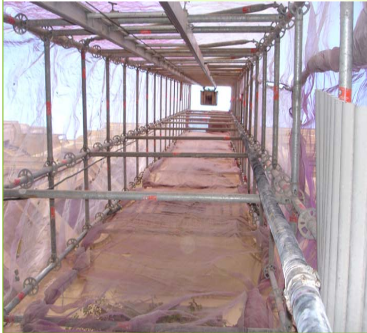
SUBIDA DE LA MANGUERA A OBRA
