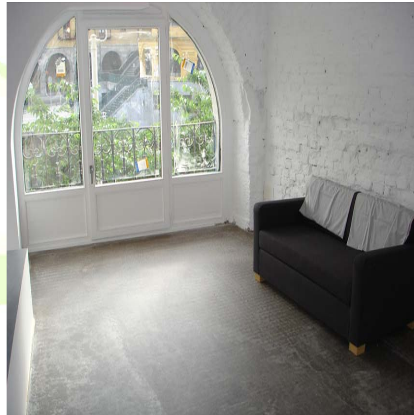
MORTERO CON HUMEDAD RESIDUAL PARA REVESTIR
