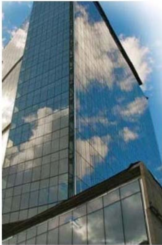
Edificio oficinas Manitoba (Canadá) Forjados Activos 64.000 m 2
