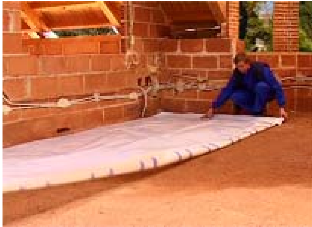
PASO 1: ZÓCALO PERIMETRAL
