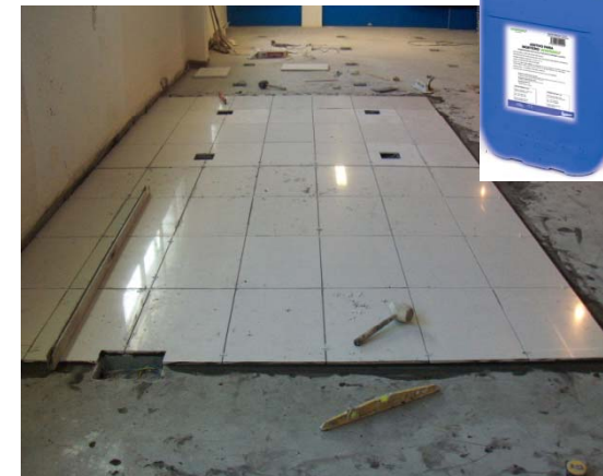
PASO 6: MORTERO Y PAVIMENTO
