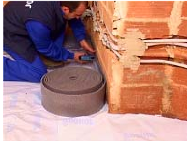
PASO 2: ZÓCALO PERIMETRAL
