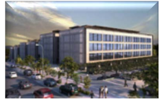
Edificio Tripark, LEED ORO
