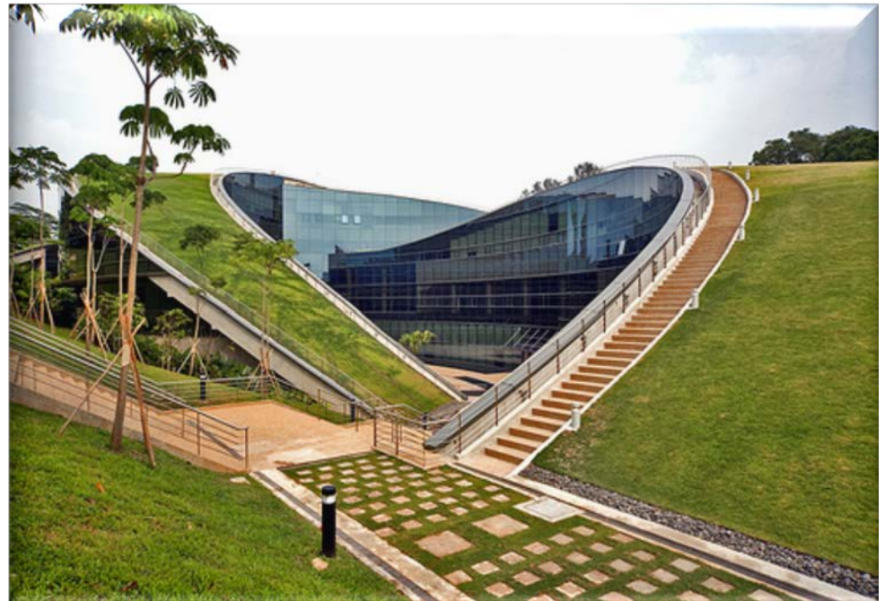
Universidad Tecnológica de Nanyang, LEED PLATA.
