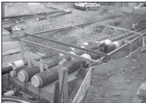
Figura 2: Red de distribución subterránea vía pública
