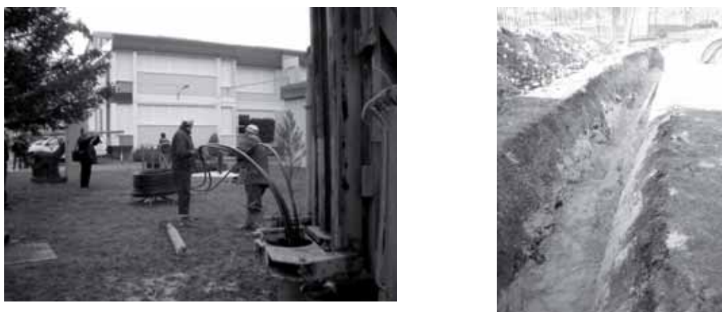
Figura 5. Instalación geotérmica tierra-agua / tierra-aire
