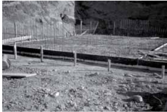
Foto 3: Solera terminada sobre aislante
