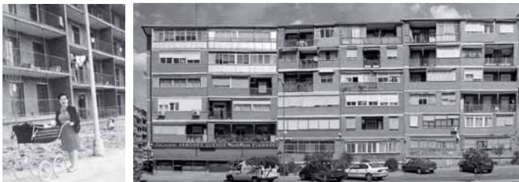
Figura 1. Fotografías del estado original de las terrazas de fachada y actual tras las intervenciones realizadas por los usuarios
