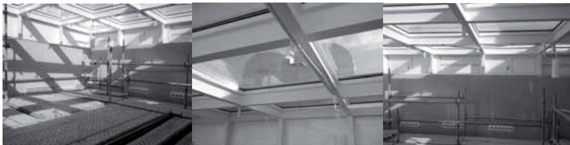
Figura 3. Revisión de las Instalaciones y medidas pasivas bioclimáticas adaptadas en el lucernario.
