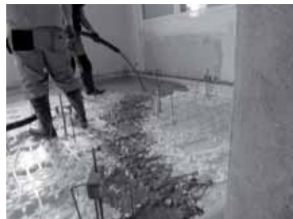
Figura 4. Instalación de suelo radiante
