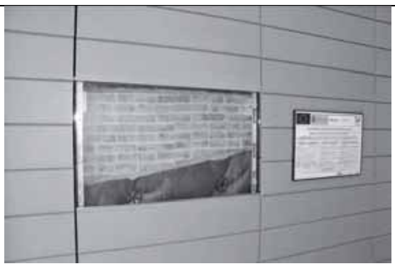
Figura 4. Detalle fachada ventilada terminada
