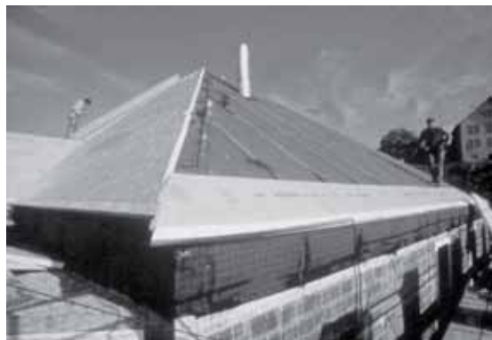
Foto 8: Construcción tejado y detalle cumbre
