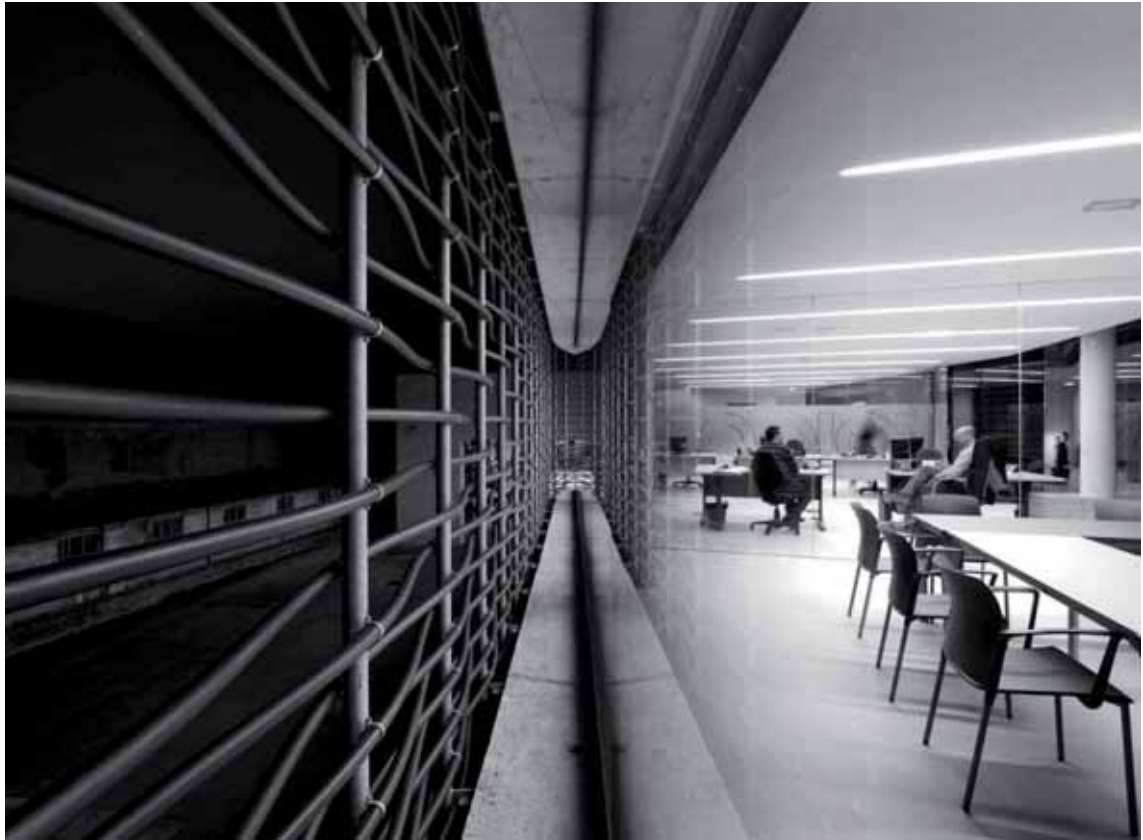
Figura 5. La piel de tuberías de polietileno se separa más a la altura de los ojos para mejorar la relación de los usuarios con el exterior.
