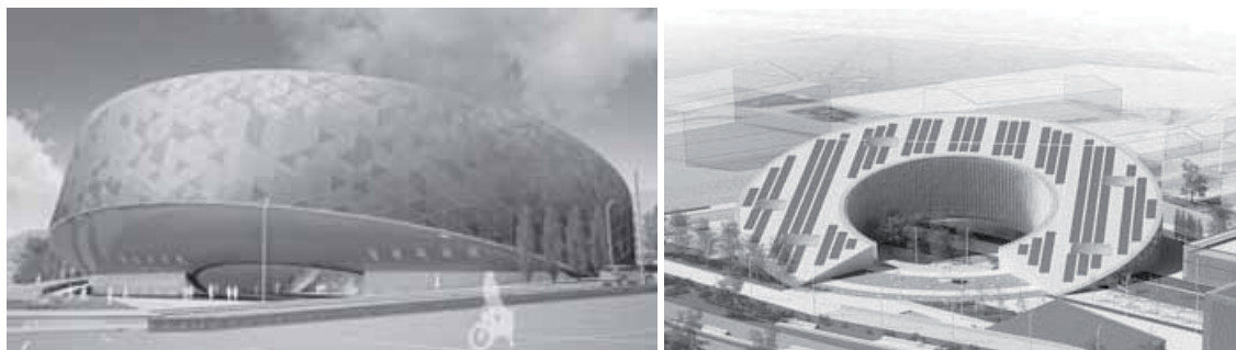
Figura 1. Vista frontal y posterior del edificio Orona Zero.
