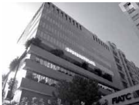
Figura 1. Vista general del edificio FIATC
