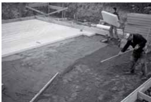
Foto 1: Aislamiento de la solera de cimentación
