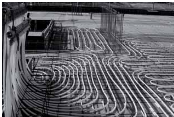
Figura 3. Instalación en obra de los circuitos hidráulicos del sistema TABS previamente al hormigonado
