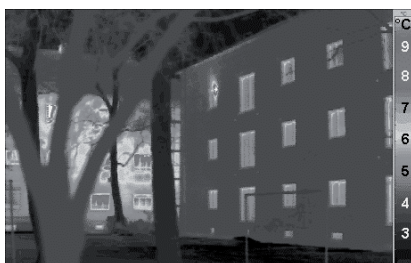
Figura 5: termografía, fuente www.essential-architecture.com
