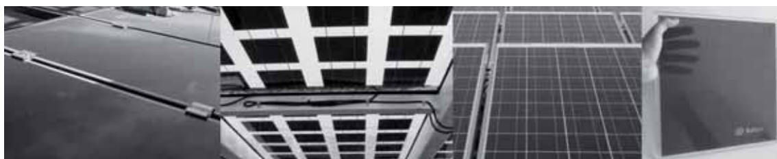
Figura 1. Diferentes paneles FV: Capa fina de telurio de cadmio, células de silicio en vidrio-vidrio, panel convencional de silicio policristalino y vidrio con silicio impreso (fotografías de Pablo Carbonell).
