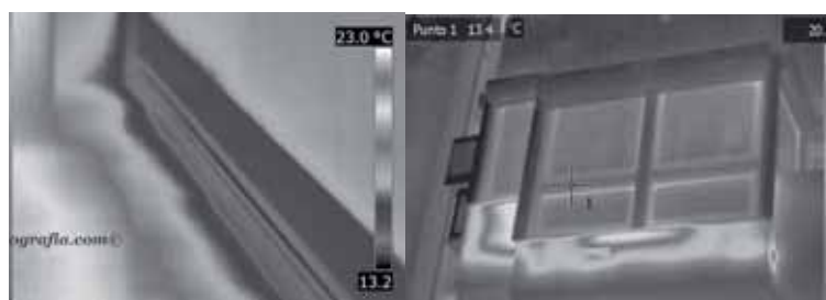
Figura 4. Imágenes tomadas desde interior y exterior de viviendas y que reflejan de filtraciones y fugas de aire respectivamente en encuentro entre la carpintería y el paramento.
