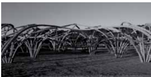
Figura 1. Estructura biomimética de caña común, realizada con fardos de cañas atadas con cuerda de esparto que se pretensan al doblarse, lo que les permite aguantar cargas y sismos.
