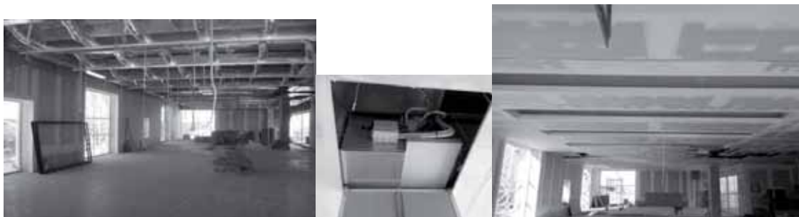
Figura 4. Revisión de las Instalaciones y supervisión hasta el acabado final en un Auditorio.
