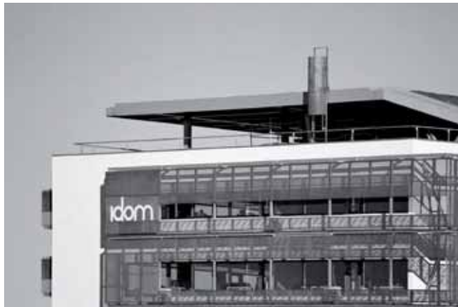
Figura 1. Edificio sede de IDOM en Madrid en el que se aprecian las protecciones solares en la cubierta y fachadas sur, y oeste del edificio.
