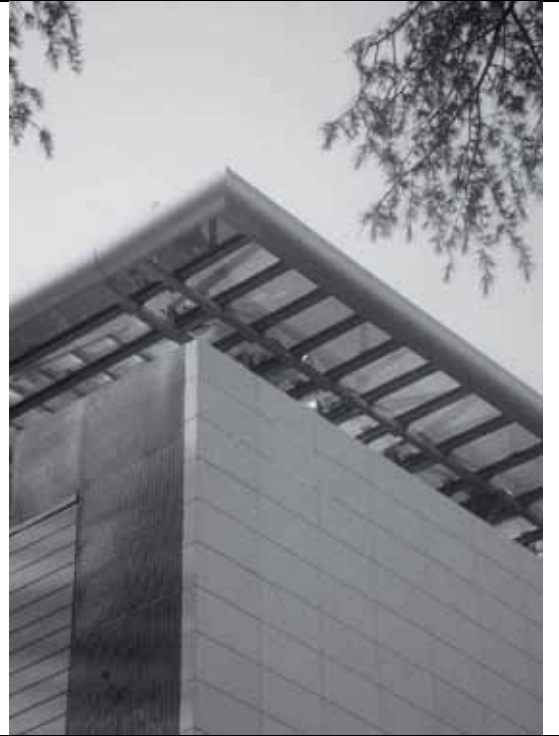
Figura 8. Detalle pérgola sobre fachada Oeste
