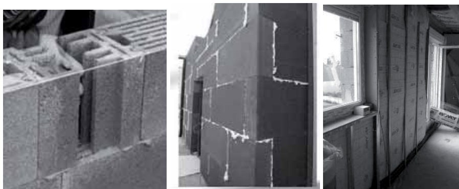
Fig 3. (a) bloques arcilla expandida (b) Sate con EPS 200mm (c) trasdosado lana de vidrio + PYL
