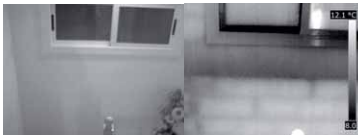
Figura 8. Imágenes de discontinuidad en el aislamiento térmico de un cerramiento. Es habitual acompañar la imagen termográfica de la imagen digital.
