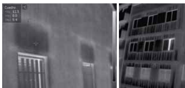
Figura 3. Imágenes de puentes térmicos: cajas de persiana y cantos de forjado.
