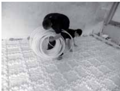
Figura 4. Instalación de suelo radiante
