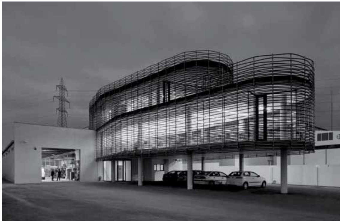
Figura 6. En el proyecto se ha buscado integrar las medidas sostenibles en la arquitectura, una de las asignaturas pendientes de la arquitectura sostenible de hoy en día.
