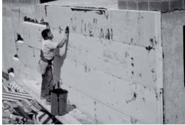
Foto 4: Aislamiento muro enterrado
