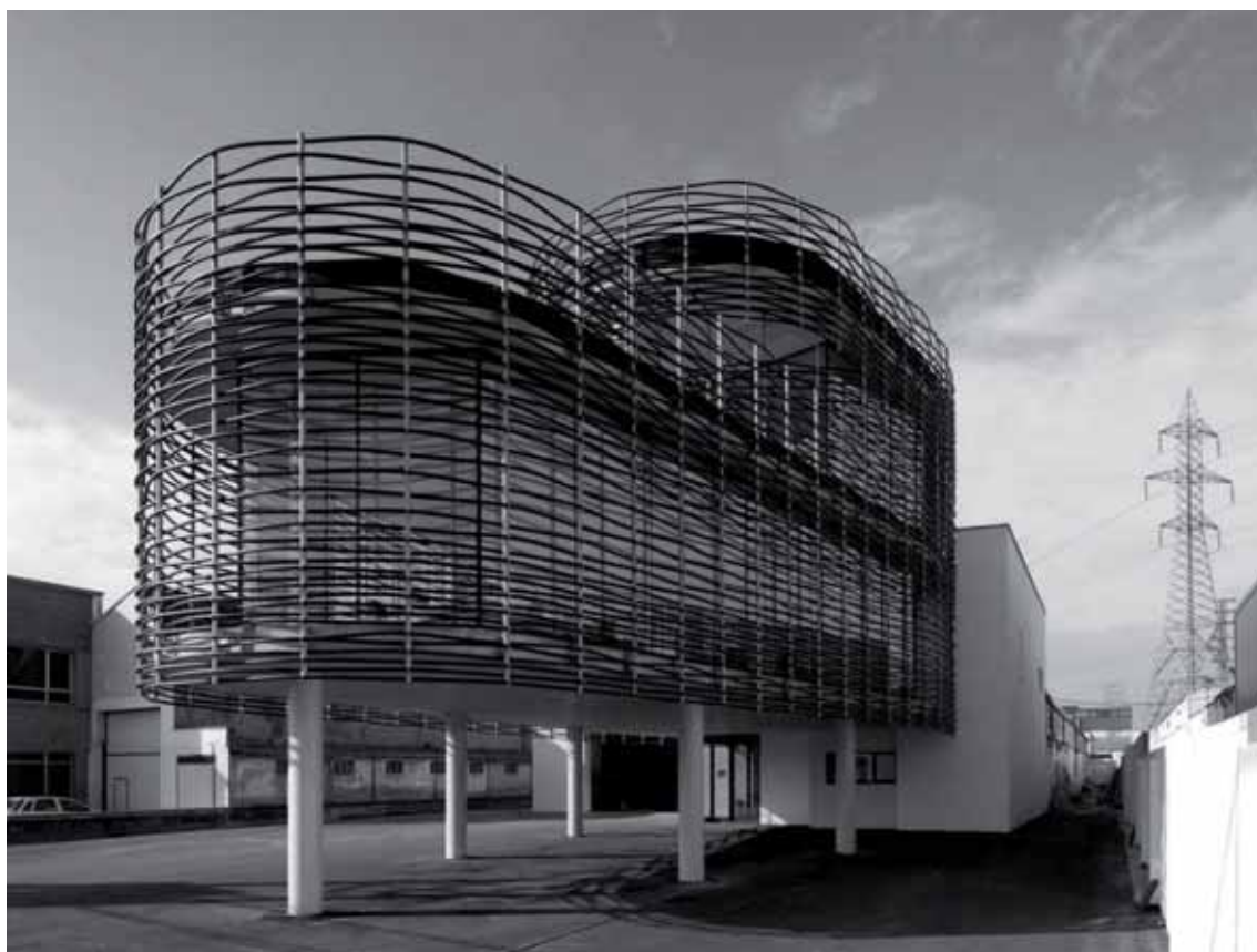
Figura 4. El porche que se genera en planta baja, permite tener un parking a la sombra, lo que genera de manera pasiva un ahorro energético.
