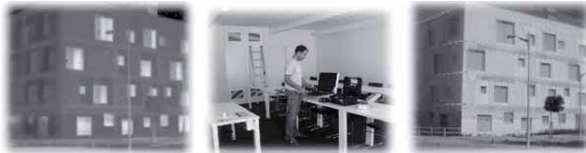
Figura 5. Imágenes de campo de algunas actuaciones desarrolladas durante el Procedimiento de Certificación Energética del Edificio de la nueva Sede de FEDA.
