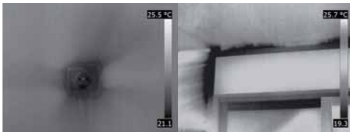
Figura 7. Imágenes de filtraciones de aire a través de un enchufe y del encuentro entre la caja de persiana y el paramento. En la termografía no se refleja el aire sino su rastro en las superficies con las que está en contacto.
