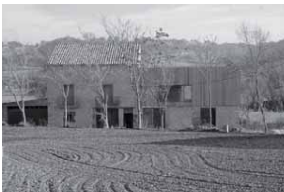
Figura 2: rehabilitación en La Segarra, J. Bunyesc, arquitecto
