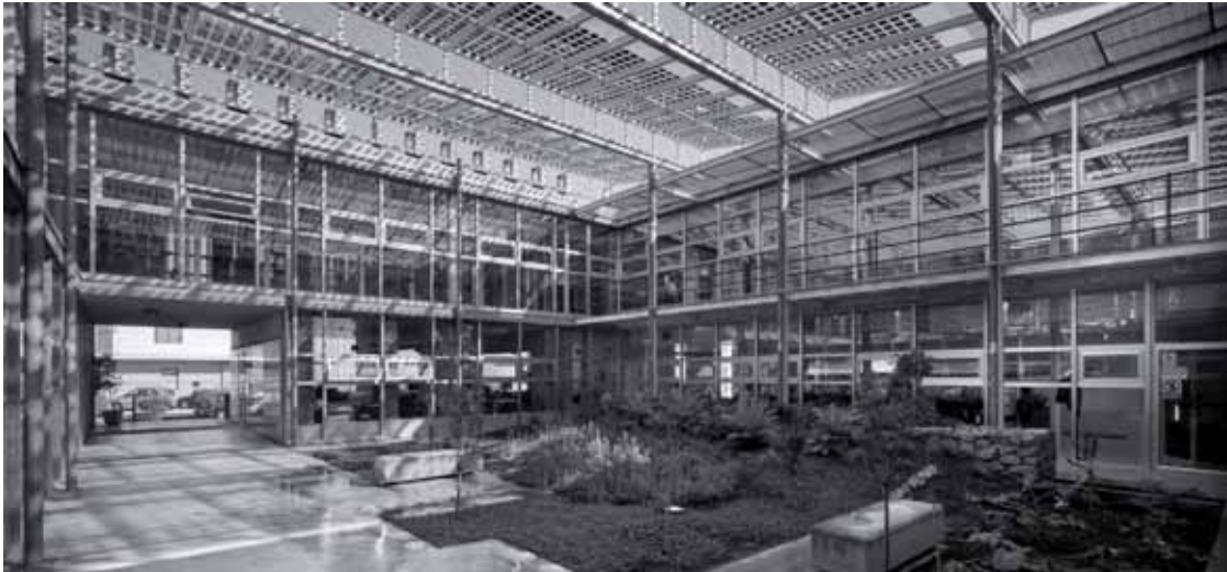
Figura 6. Imagen del patio interior del BORM, espacio donde convergen gran parte de las estrategias bioclimáticas y de integración arquitectónica de la instalación fotovoltaica (Fotografía David Frutos).
