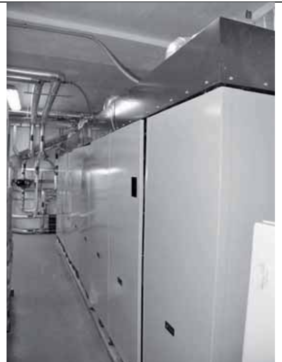
Figura 11. Sala máquinas de absorción (frío solar)
