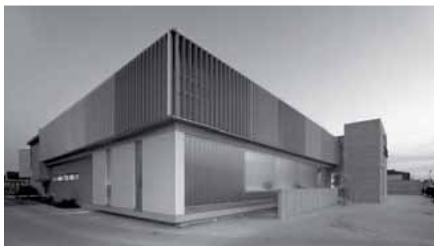
Figura 4. Exterior del edificio del BORM. Ampliación y actuación en fachada (Fotografía David Frutos).
