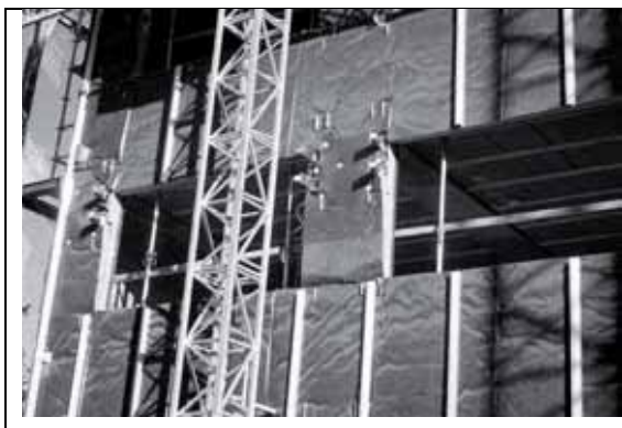
Figura 3. Construcción de la fachada ventilada
