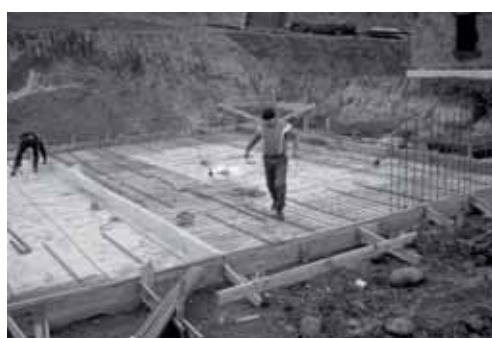
Foto 2: Instalación de las armaduras de la solera
