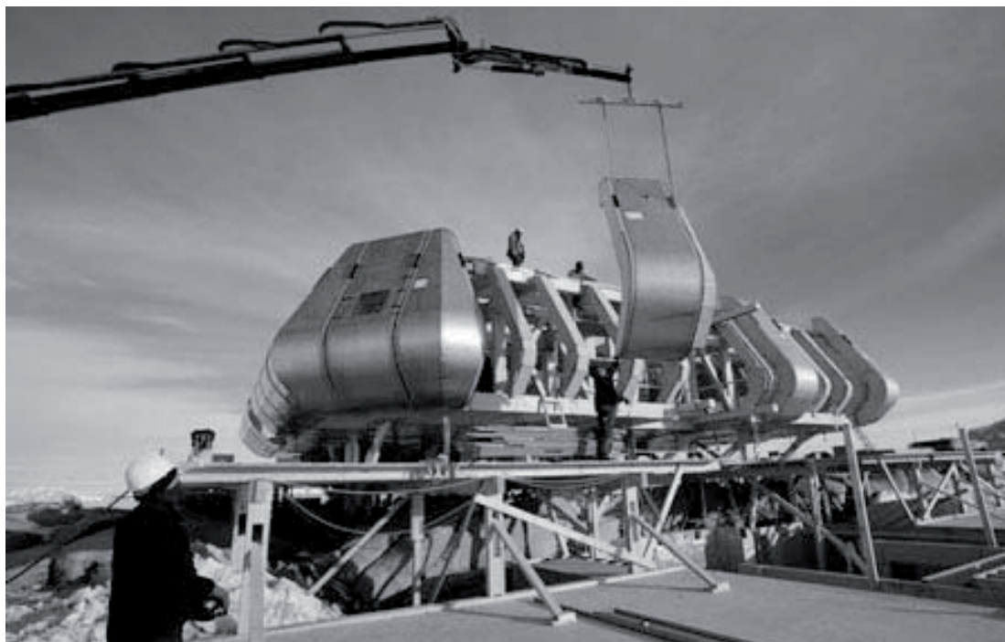
Figura 2. (René Robert - International Polar Foundation). Construcción de la PEA.
