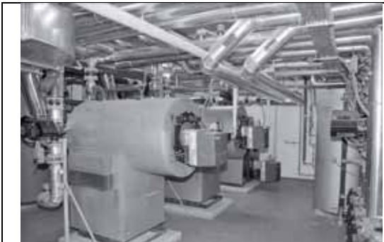
Figura 9. Sala máquinas de producción de calor
