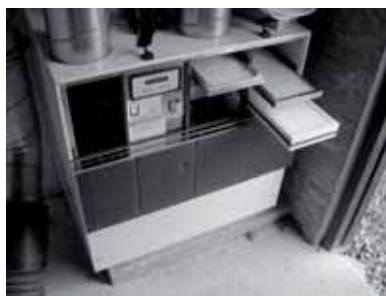
Figura 6: recuperador de calor. Vivienda en Roncal, Wolfgang Berger, arquitecto
