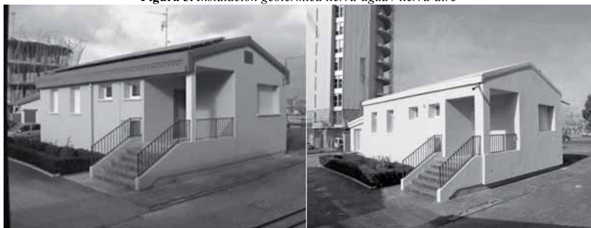
Figura 6. Antes y después de rehabilitar
