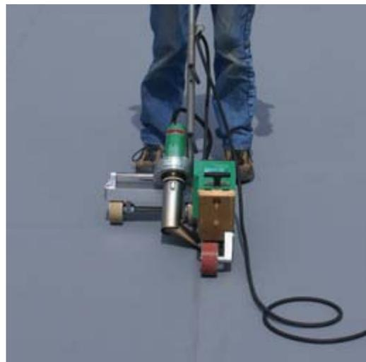
Instalación con la ayuda de una máquina de aire caliente
