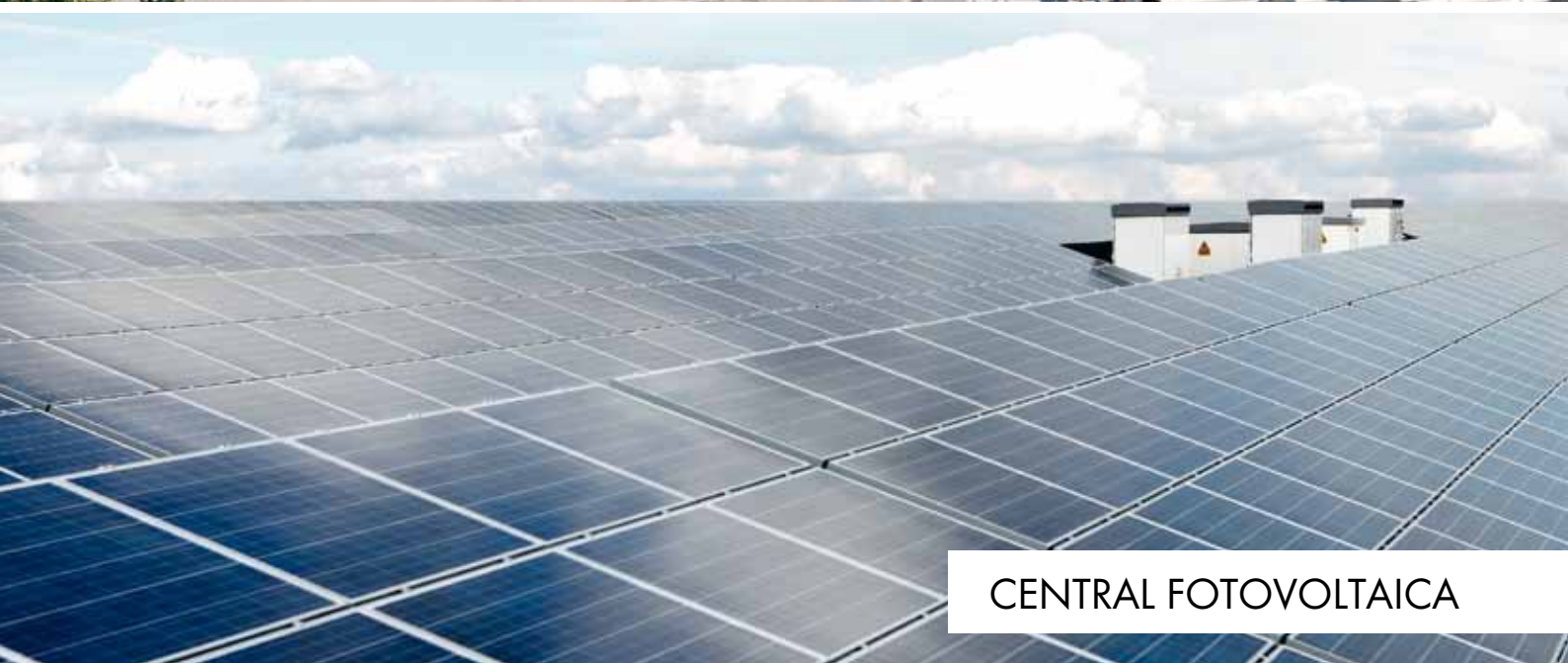
INSTALACIÓN FOTOVOLTAICA INDUSTRIAL
