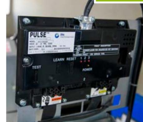
El sistema PULSE monitoriza el estado de las cintas las 24 horas del día y supone un refuerzo a la normativa vigente en materia de vigilancia, mantenimiento y fiabilidad de su ascensor.
