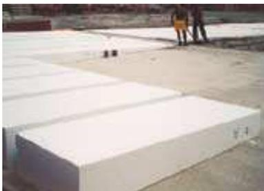
pueden soportar grandes empujes verticales u horizontales. Cuando se utiliza como material de relleno en taludes previene posibles problemas de asentamiento, de difícil y cara reparación.
