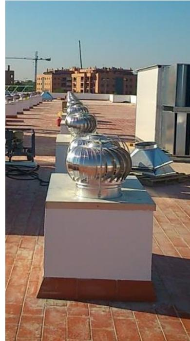
Aireador dinámico: mejor funcionamiento , incrementa su eficacia si además se le dota de un motor para funcionamiento híbrido
