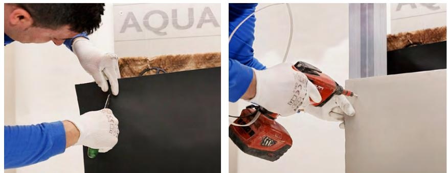
La membrana se debe cortar en los puntos de encuentro con las ménsulas y trabarse temporalmente hasta la colocación de la estructura adecuada según la fachada ventilada proyectada.
