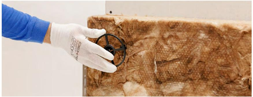
Instalación de la lana mineral Naturoll 032 y colocación de las fijaciones.
