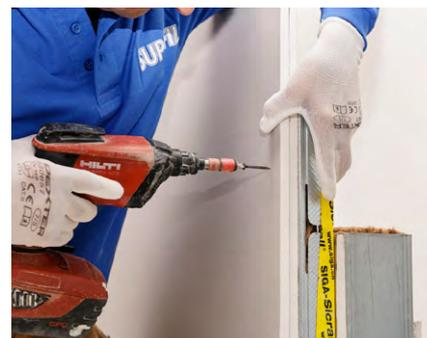
Relleno de la perfilera de 48 mm con lana mineral Ultracoustic O35 en 50 mm y trasdosar con doble placa de yeso laminado Knauf tipo A. Fijar las escuadras o ménsulas de la fachada con los anclajes adecuados definidos por el fachadista. Posteriormente instalar las esperas de las fijaciones de la lana mineral.
