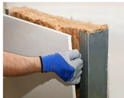
Atornillar la placa de yeso laminado a los montantes de Aquapanel.
