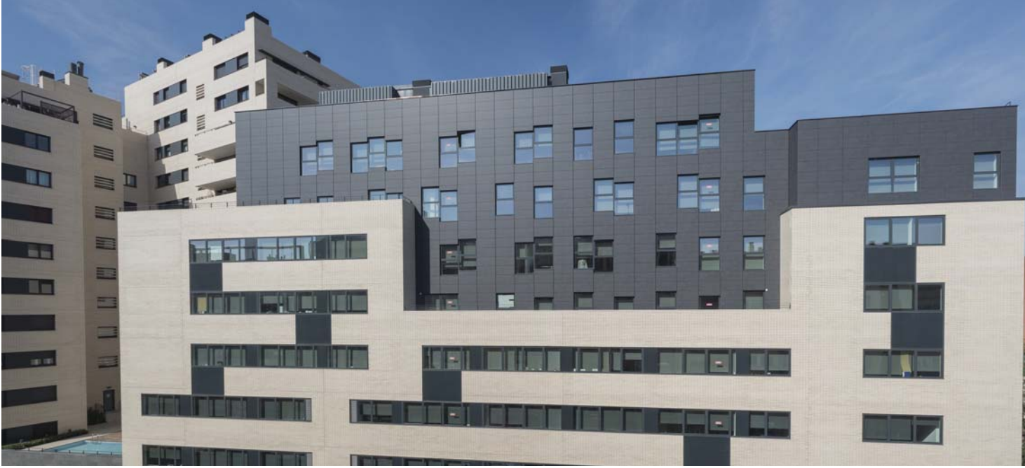
Oficinas Pere Quart, Barcelona. Instalador: Sistema Massa.
