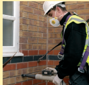
3. Proceso de insuflado.
