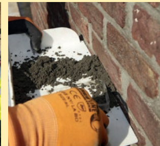
4. Sellado de agujeros y acabados.
