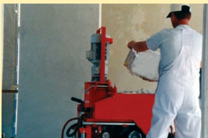
1. Mezcla del mortero
