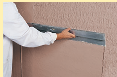
3. Regularización de la superficie
