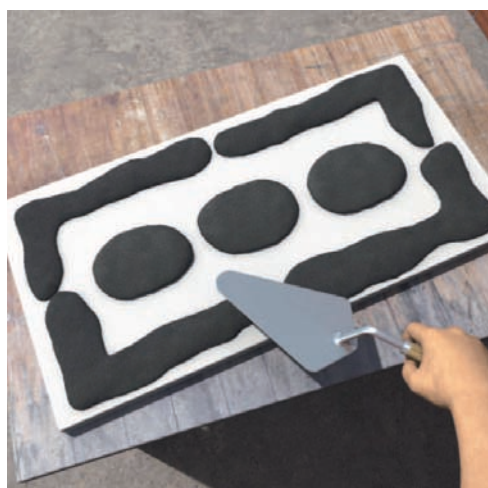
Método de Cordón de Mortero
