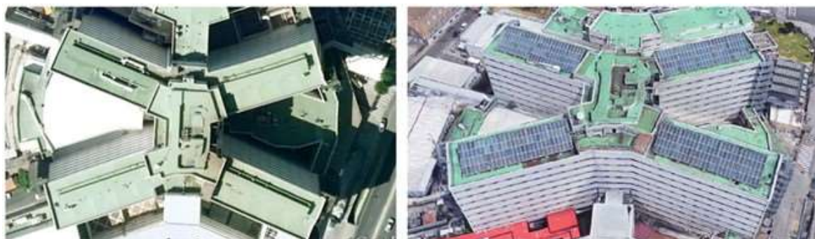
Figura 3: Cubiertas de un hospital antes y después de implantar la instalación solar térmica
