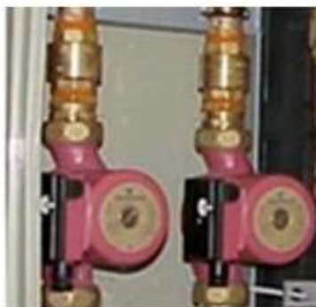
Figura 77: Ejemplo de válvula de retención, instaladas en impulsión de bombas y símbolo habitualmente utilizado
