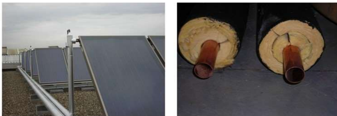
Figura 101: Acabado de aislamiento en chapa de aluminio (izq.) y preparación de tuberías con aislamiento de lana de vidrio para montaje al exterior protegido con venda y emulsión asfáltica como barrera de agua y vapor (der.)
