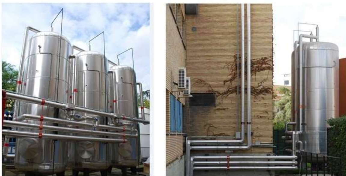
Figura 98: Montaje de acumuladores solares en el exterior y los circuitos hidráulicos que los conectan
