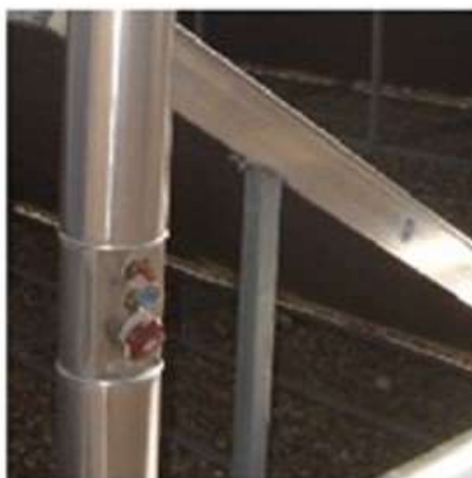
Figura 78: Dos tipos de válvulas de equilibrado, instalada con mando accesible y símbolo habitualmente utilizado
