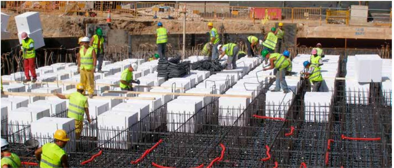
Los casetones y bovedillas de poliestireno expandido permiten optimizar los costes de la edificación y al mismo tiempo mantener las características de seguridad y funcionalidad.
