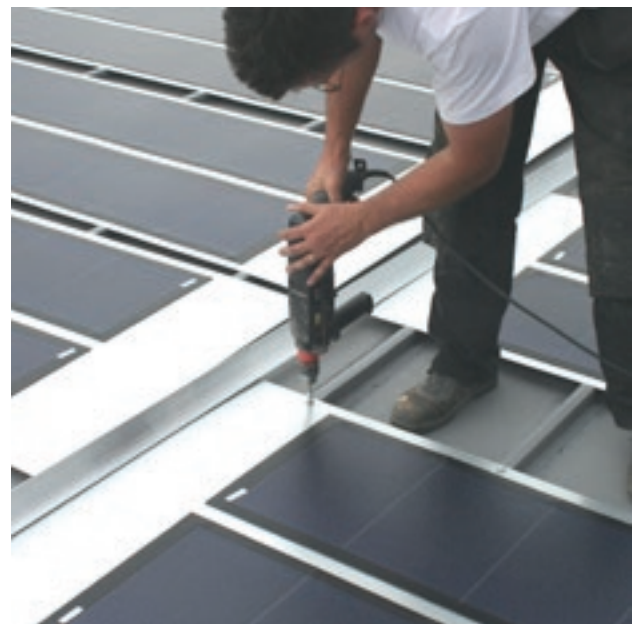
Remplazar paneles sin riesgo de dañar la lámina impermeable.
