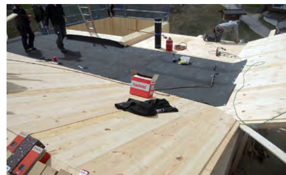
Seguridad contra caídas y cartón bituminoso
