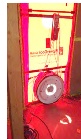
Realización ensayo Blower door. Vivienda Valdemorillo. RC Arquitectura y 100x100madera Valor n50 = 0,45 ren/h Capa estanqueidad: Tableros superPan Tech P5, acompañados de cintas de estanqueidad para tratamientos de juntas, encuentros y fijaciones.
