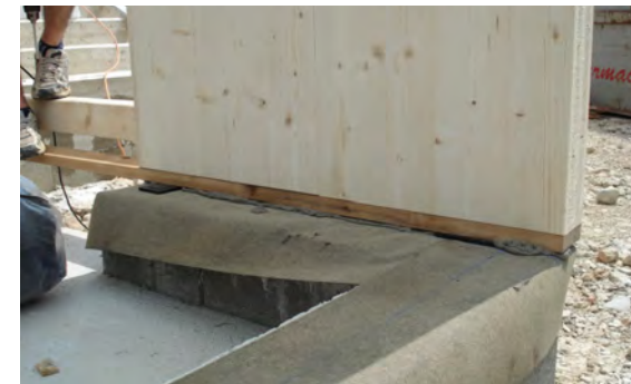
Umbral de alerce y sellado contra la humedad ascendente
