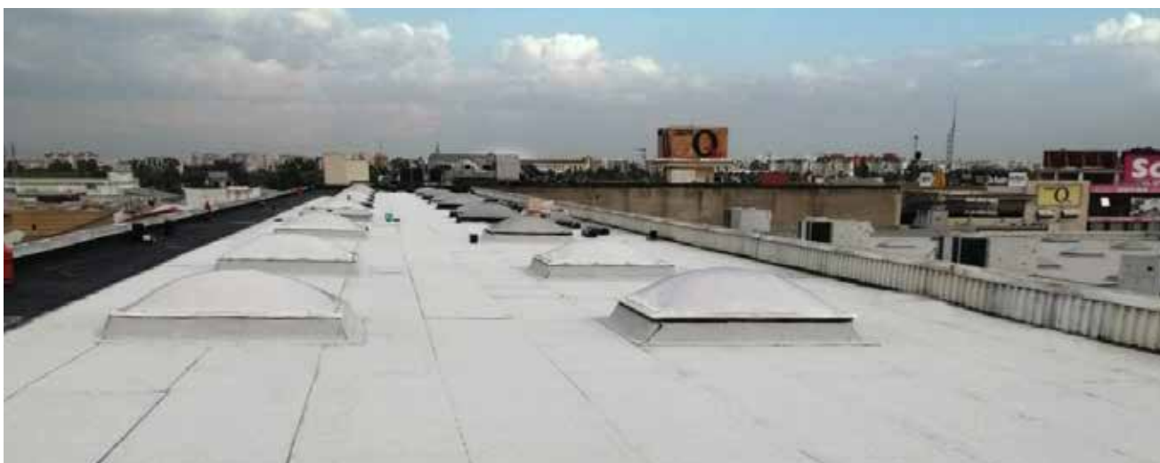
CUBIERTA DECK MONOCAPA
